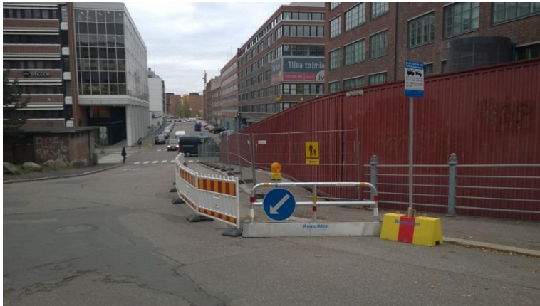
KUVA 15. Kevyen liikenteenväylä siirretty ajoradalle Helsingin mallin mukaisesti (Kuva: Ramudden)
