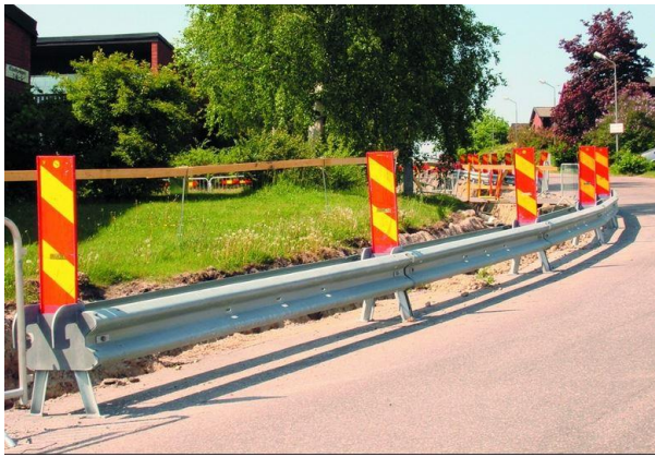
KUVA 20. CityGuard:in kiinnitettyä sulkulevyjä (Kuva: Ramudden)
