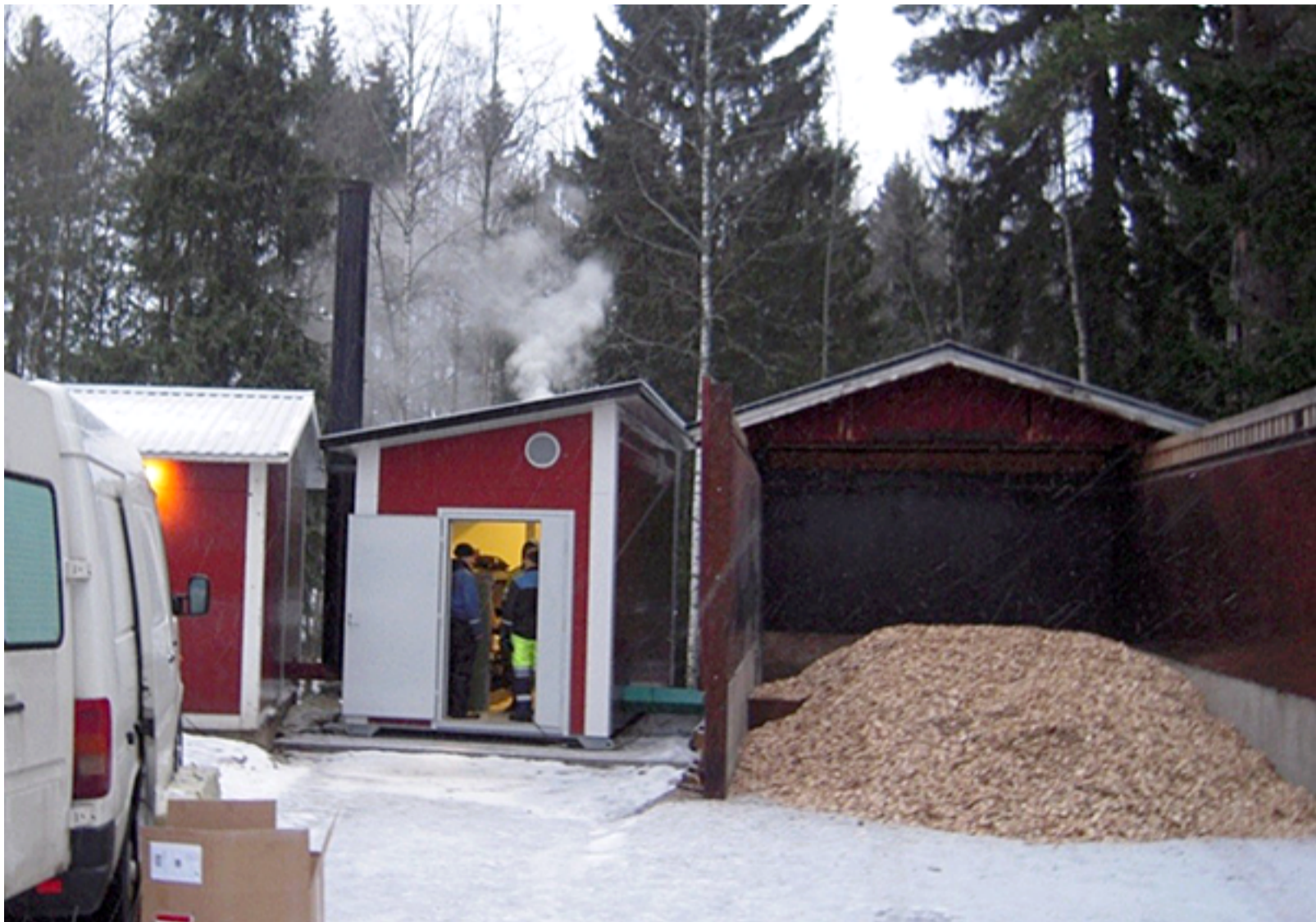
KUVA 1. Volterin CHP-laitoksen koekäyttöä 19.12.2013 Alpuan kylätalolla Vihannissa. Voimalaitos kuvassa keskellä. (Kuvaaja: Heikki Keränen)
