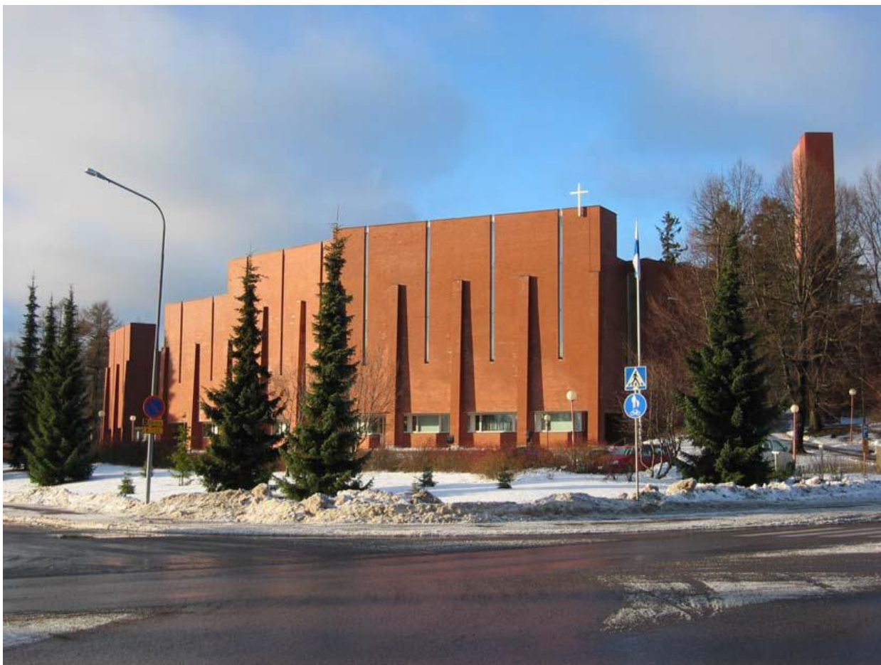
Kuva 4:Olarin kirkko. Julkisivu etelästä (Olarin kirkon peruskorjaus: hankesuunnitelma)
