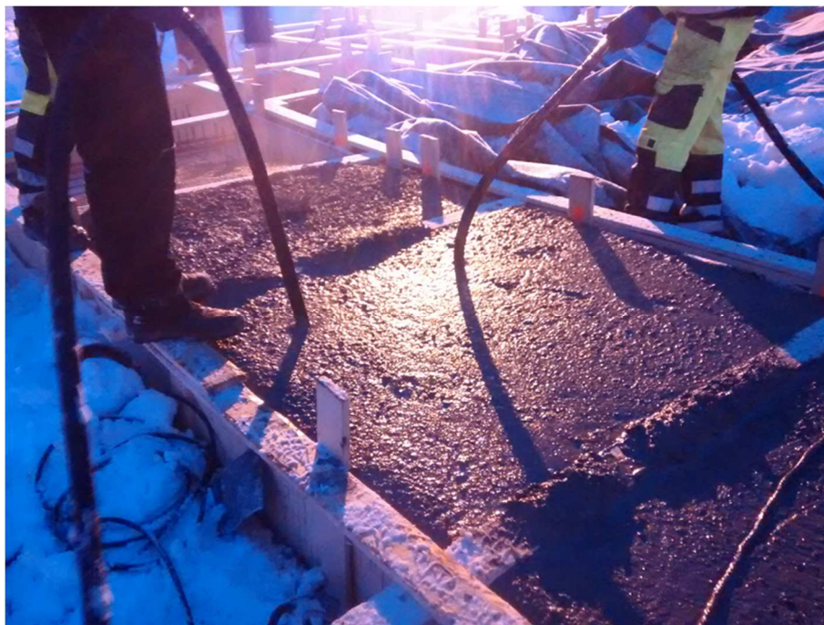
Kuva 15: Betonin tiivistämistä sauvatäryttimillä
