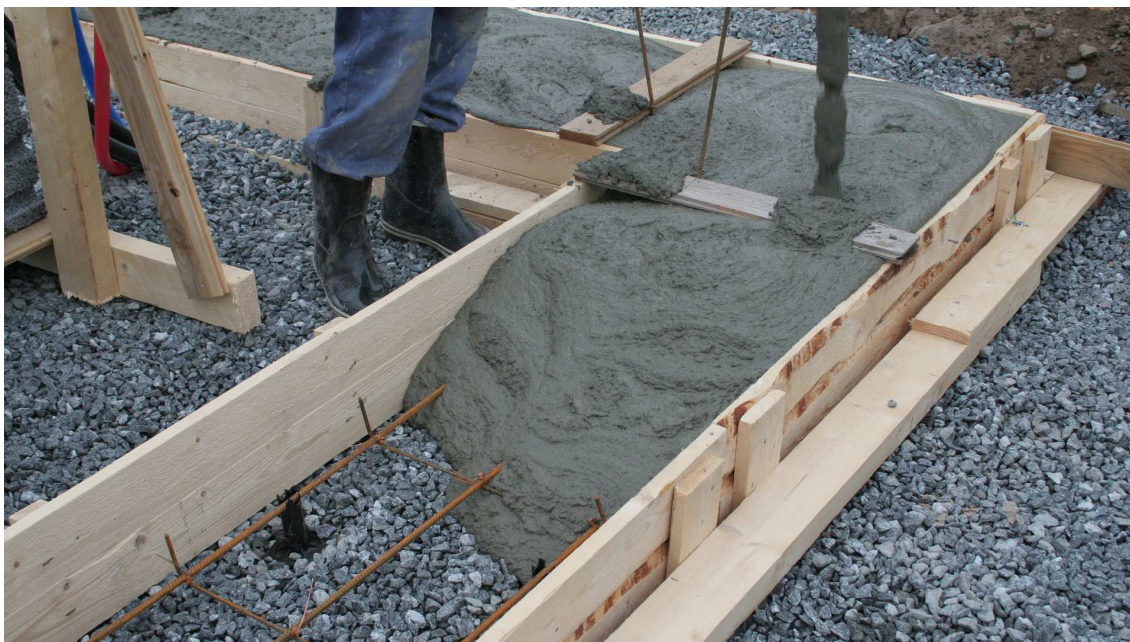
Kuva 12: Tuore betonimassa pientalon anturamuotissa [30.]
