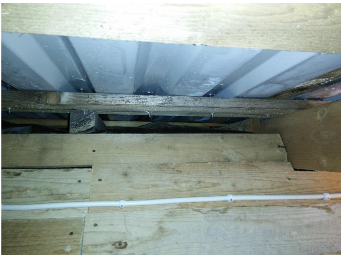
KUVA 3. Katon tuuletus ja rakenne huoneiden kohdalla (Esa Pääkkönen 2014)
