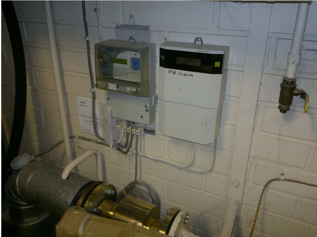
LVI-kuva 5. Kaukolämmön kulutuksen etäluettava mittari alueella 2.
