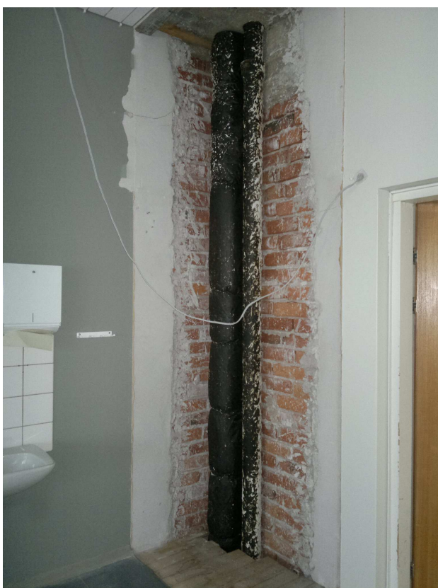
LVI-kuva 14. Kolmannen kerroksen luokkahuoneesta puretun kotelon sisällä kulkevat sadevesi- ja tuuletusviemäriputket.
