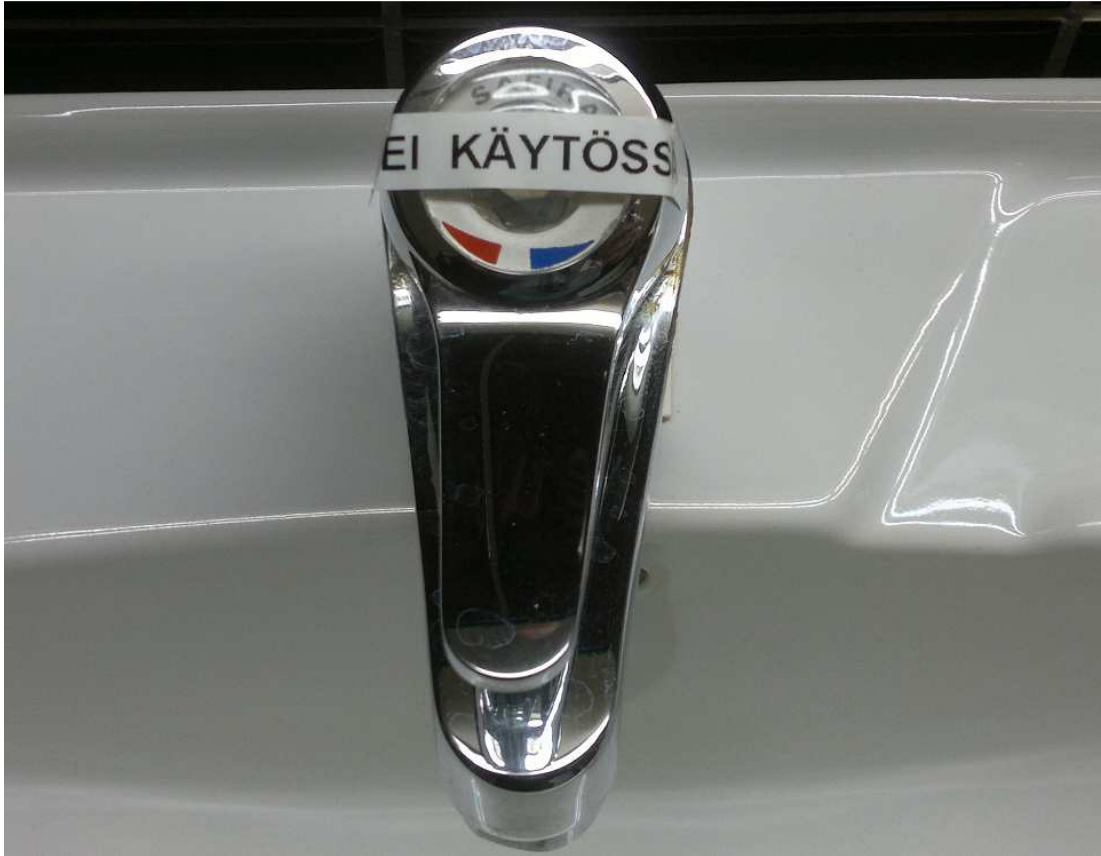
LVI-kuva 15. Käytöstä poistettu hana alueella 2, johon ei enää saa varaosia.
