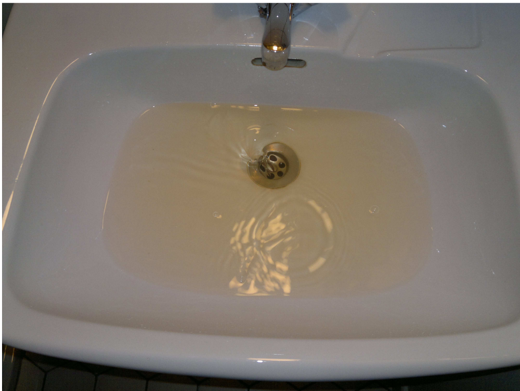
LVI-kuva 12. Kylmää vettä putkistosta mittauksen yhteydessä alueella 1.
