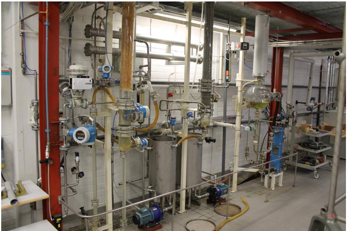
KUVIO 9. Työssä käytetty absorptio-desorptiolaitteisto
