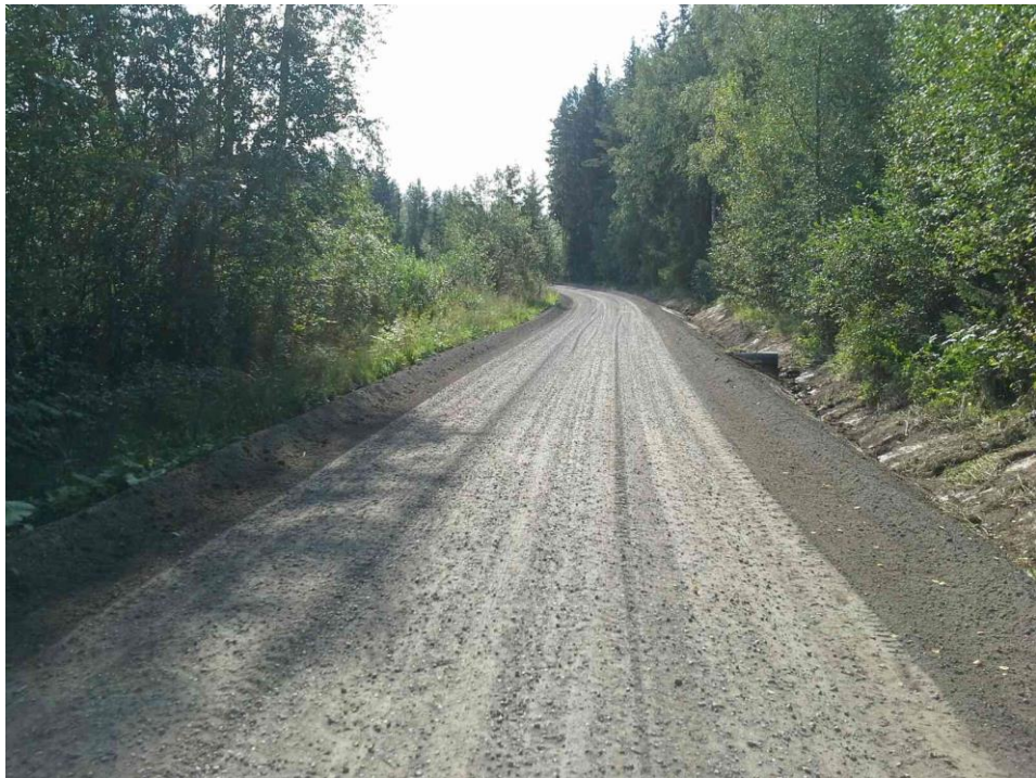
Kuva 2. Kelirikkorjauskohde avattu (Tommi Kolsin arkisto 2014).
