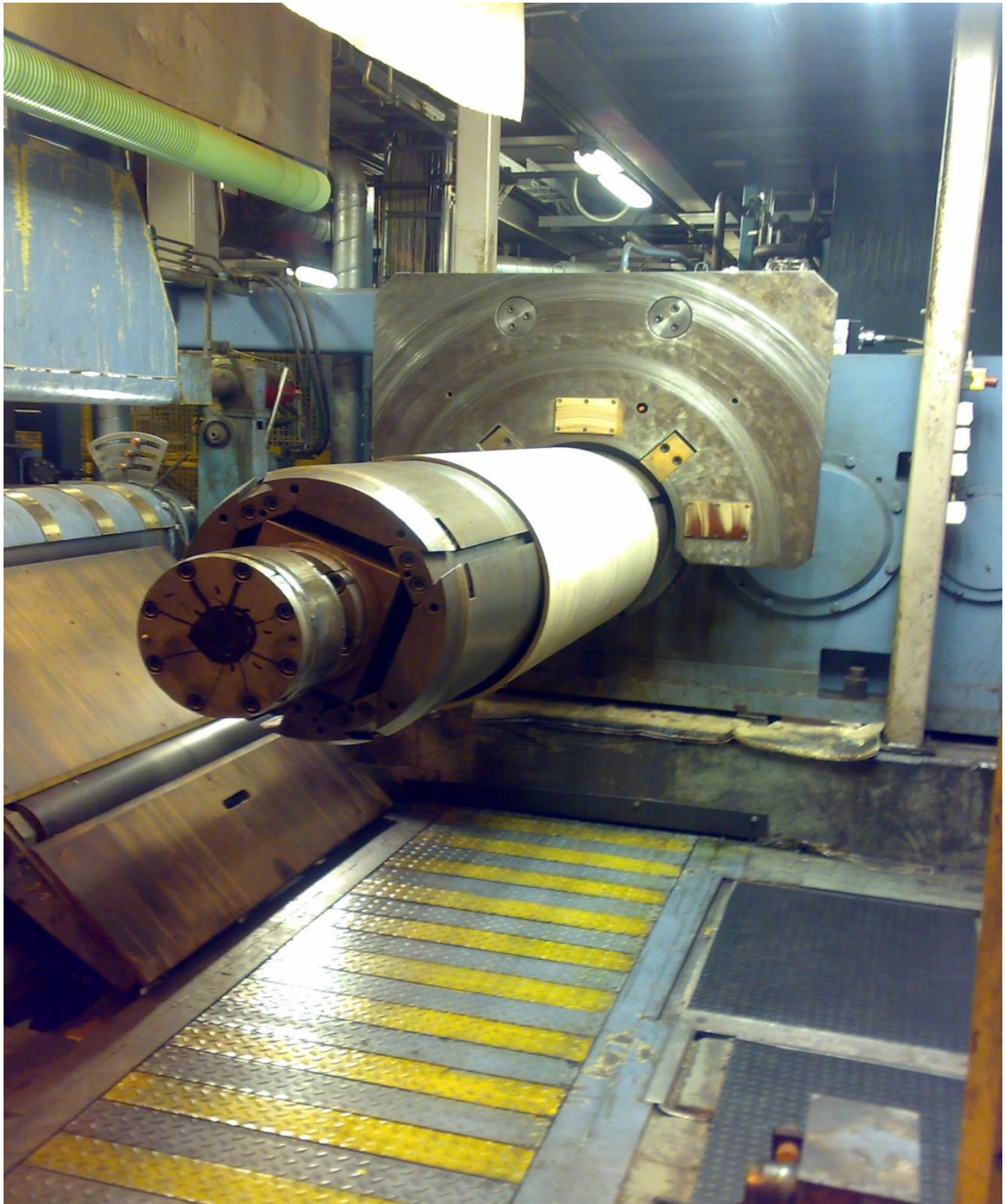
Kuva 16. Pahvihylsy asennettuna VV2 K2. (Outokumpu 2015 c.)
