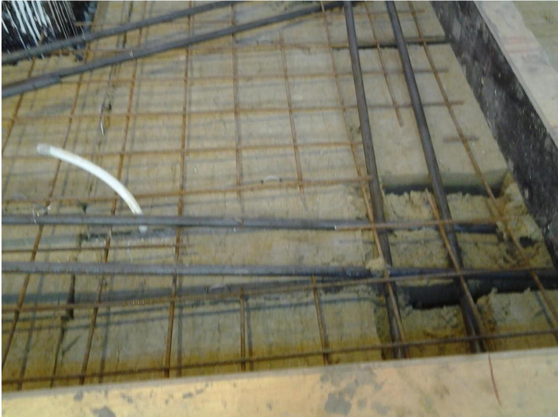
Kuvio 15. Suoran nostolenkin asentaminen sisäkuoreen
