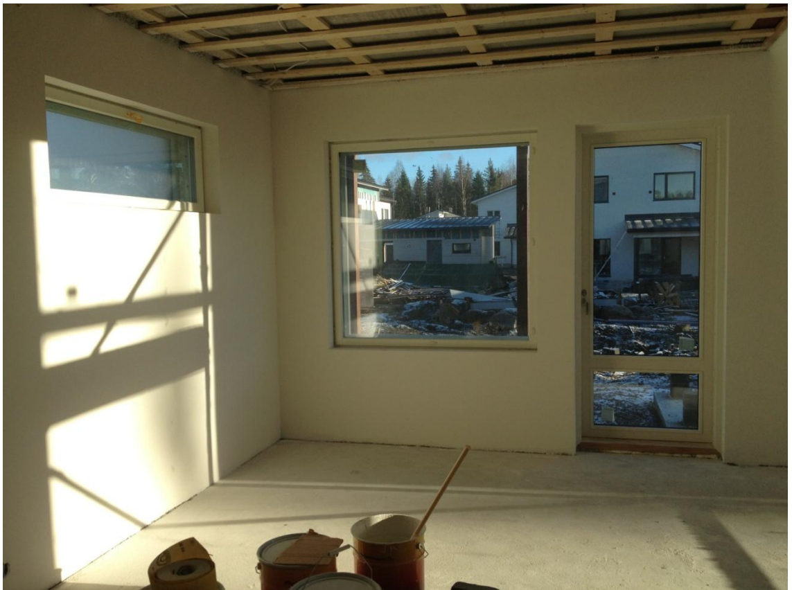
KUVA 16. Ruokailutilan käynti terassille, pohjoissivulla mattalasininen ikkuna
