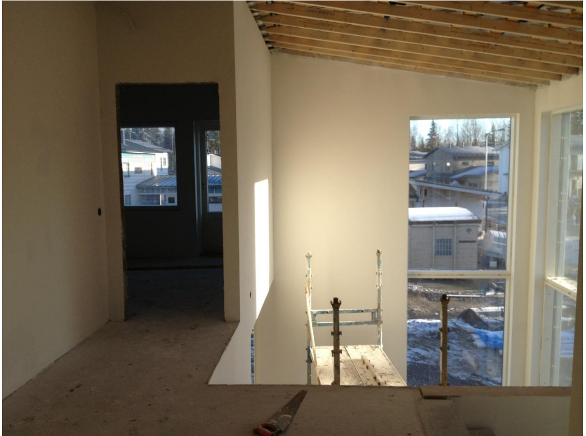
KUVA 15. Ikkunat ja ovet asennettu, turvakaiteet irrotettu seinäpintojen tasauksen ja maalauksen ajaksi
