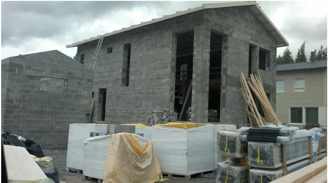
KUVA 12. Rakennusten runko pystyssä
