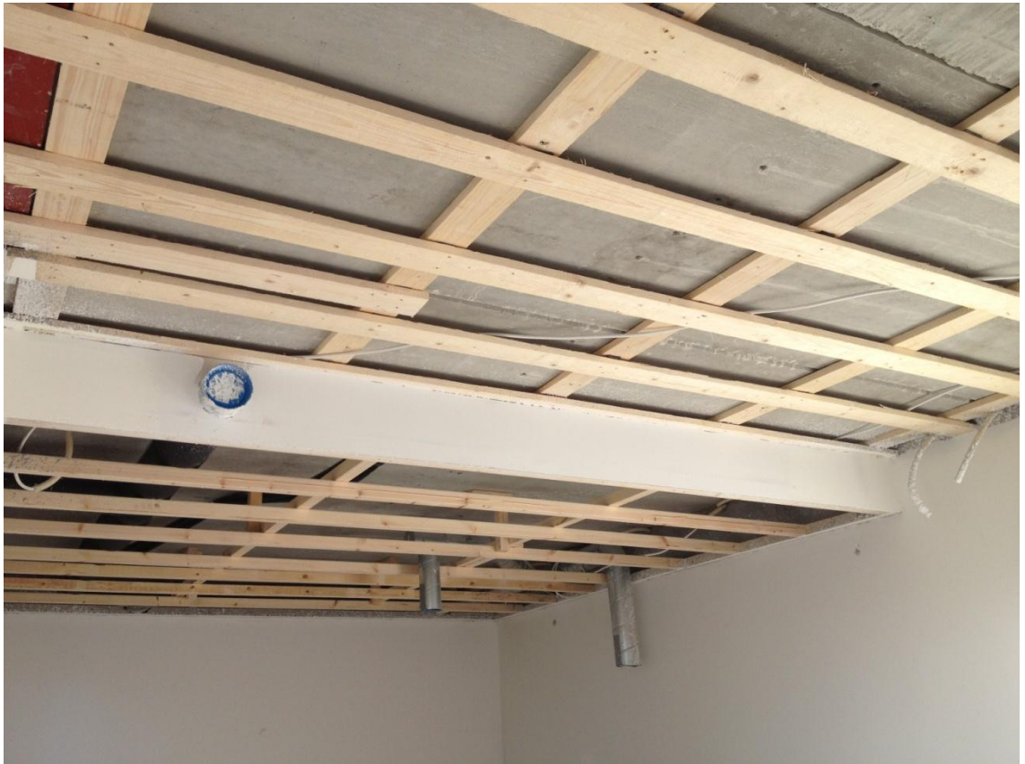
KUVA 13. Keittiön ilmanvaihtoputkien alaslasku
