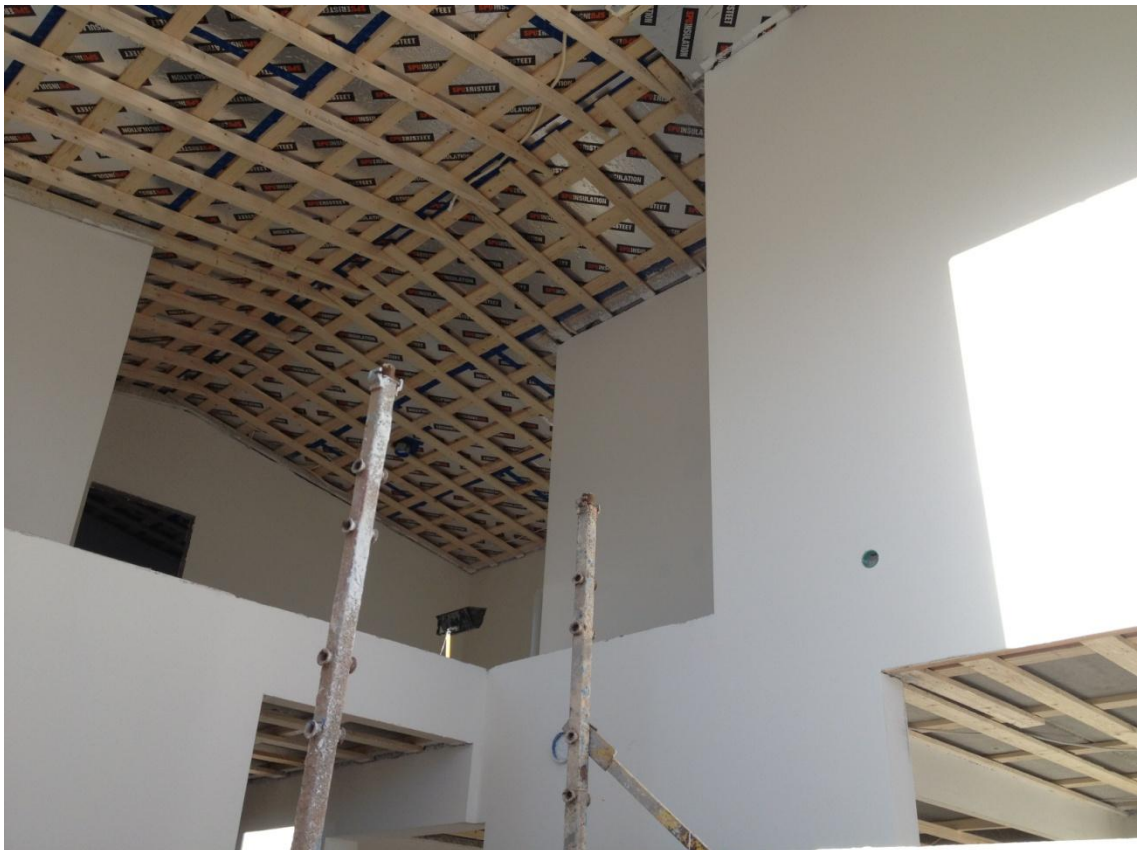
KUVA 14. Katon höyrynsulkulevyt ja koolaukset rakennettu, seinät tasoitettu ja maalattu (huomioi katon upotettaville spottivalaisimille tehty alaslaskun koolaus)
