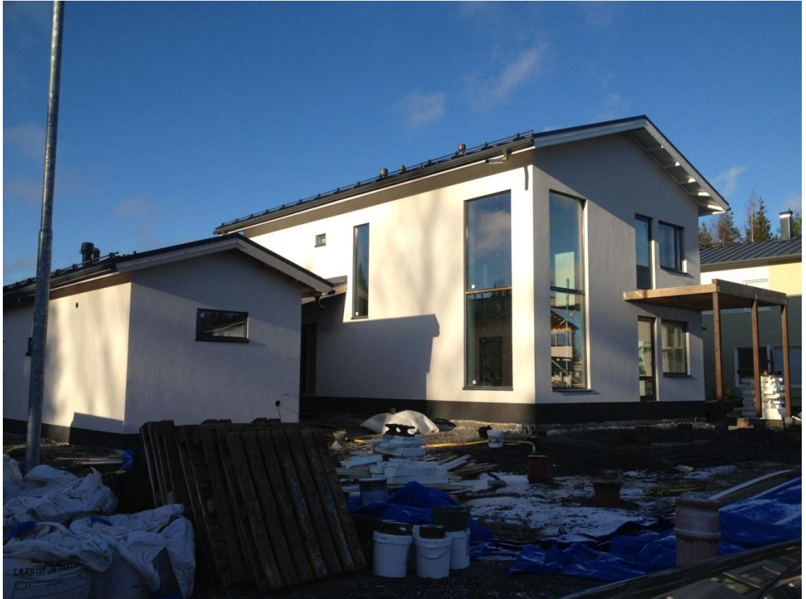
KUVA 17. Ikkunat asennettu, pinnat rapattu ja parvekkeen kantavat rakenteet rakennettu
