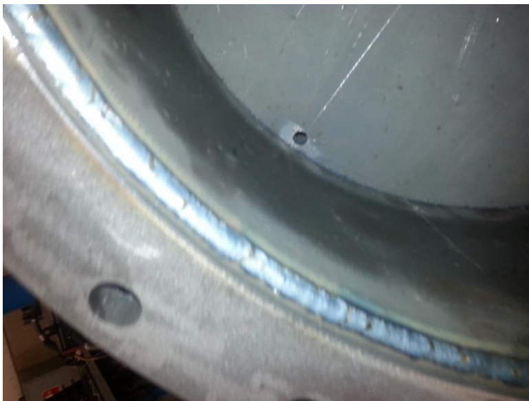
KUVA 18. Jatkopala hitsattuna. Päätylaipassa vesitäytön kierreikä (Kuva: Olli Isomäki 2014)
