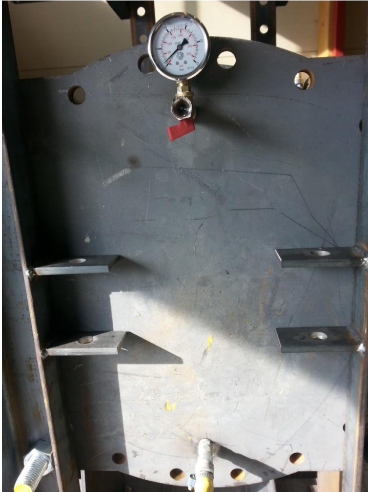
KUVA 23. Palkeen pääty. Vaadittu paine on saavutettu. (Kuva: Olli Isomäki 2014)
