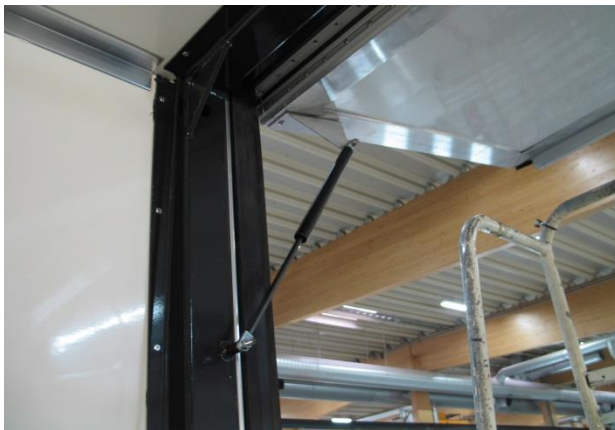
KUVA 12. Luukun kaasusylinterin asennus (Fokor 2015)
