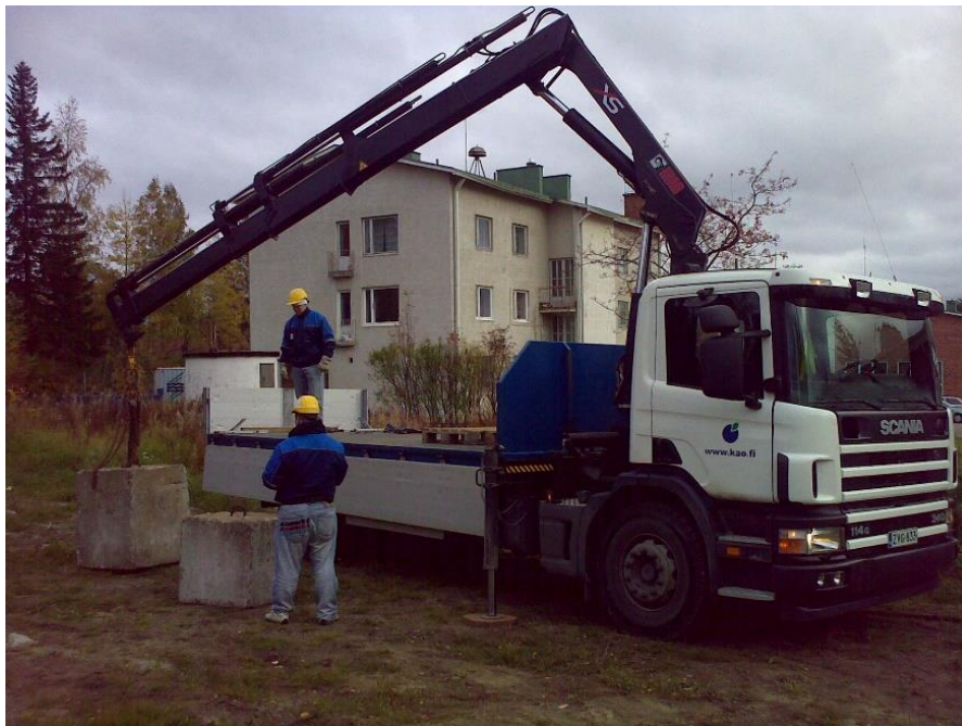
Kuva 47. Nosturiautolla harjoitellaan betonipainojen kuormaamista.
