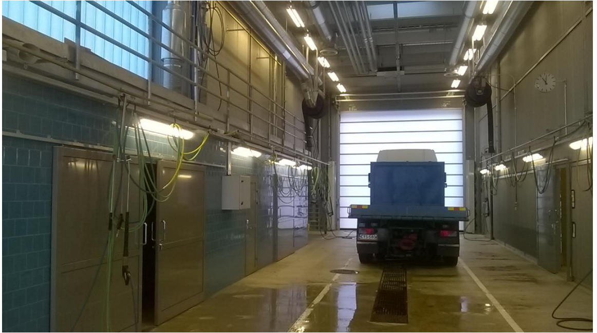
Kuva 22. Pesuhallin kävelyramppi vie paljon tilaa hallin leveyssuunnassa (Jyväskylän aikuisopisto).
