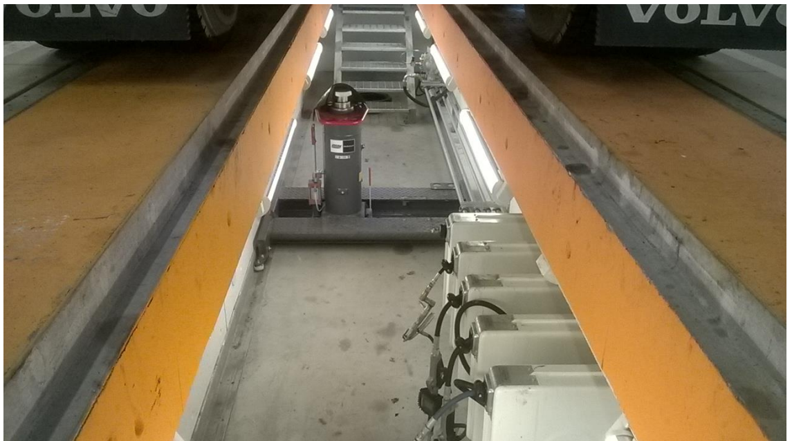
Kuva 19. Huoltokuilu läpiajettavassa hallissa, taustalla liikuteltava akselinnostin, etualalla nesteille tarkoitettut kelat (Jyväskylän aikuisopisto).
