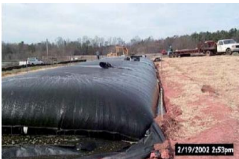
Kuva 5. Geotuubi (Worley ym. 2005)
