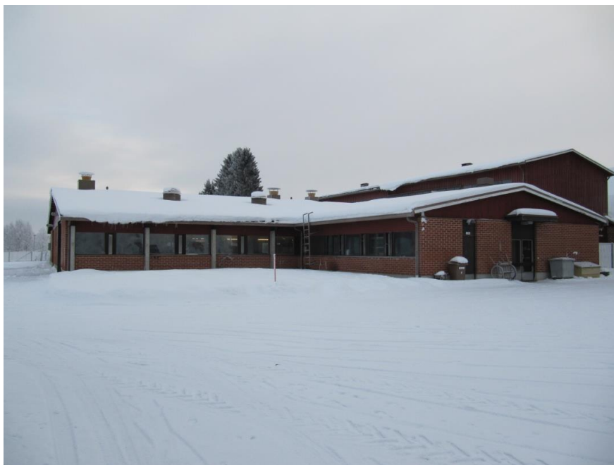
Kuva 14. Luken tutkimusmaatilán vanha navettarakennus ulkoa (Kuva: Ollikainen, 2015-01-14) (Rae.savonia.fi.)
