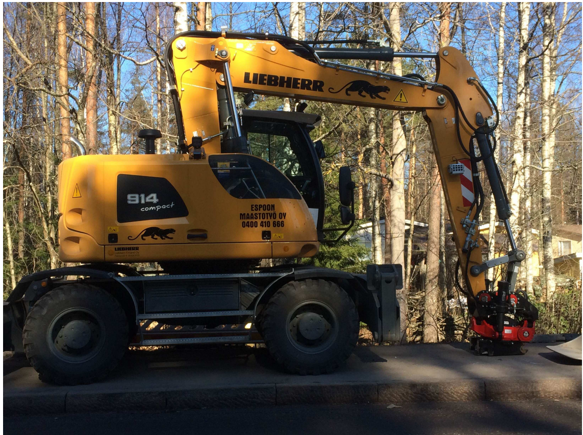
Kuva 6. Liebherr 914 pyöräalustainen kaivinkone taittopuomilla sekä indexator kauhanpyörittäjällä.
