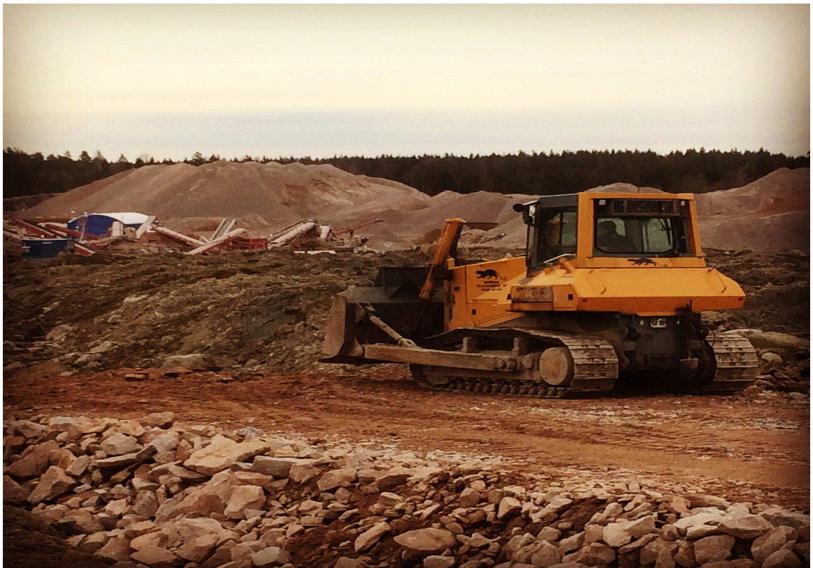
Kuva 9. Liebherr 734 puskutraktori kivitietä puskemassa Kulmakorven läjitysasemalla
