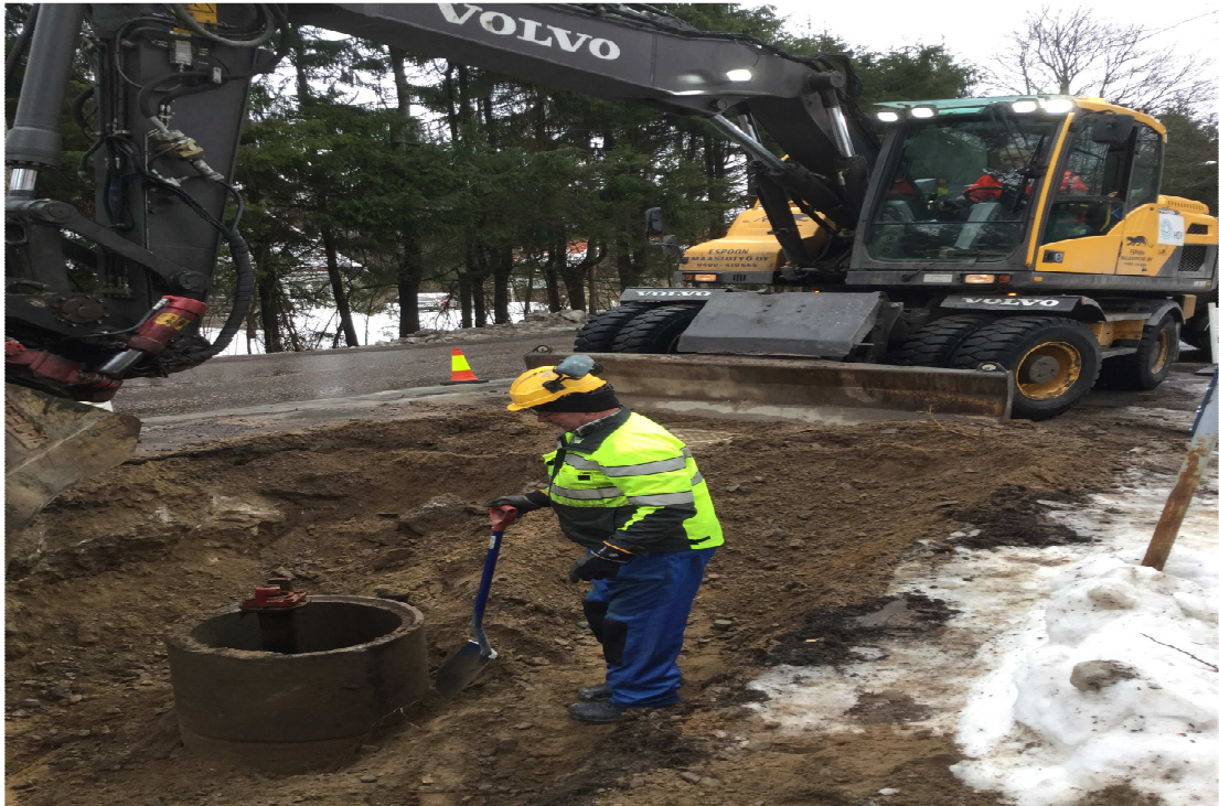
Kuva 3. Perämies työskentelee kaivannossa oikeanlaisessa varustuksessa
