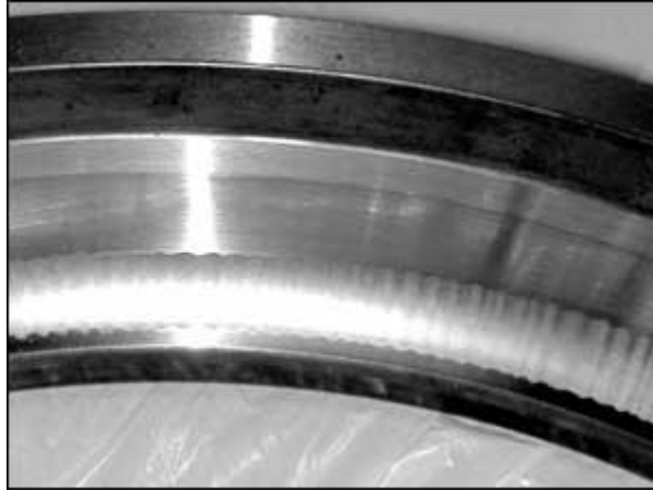
Kuva 12 Laakerivirran aiheuttama vaurio
