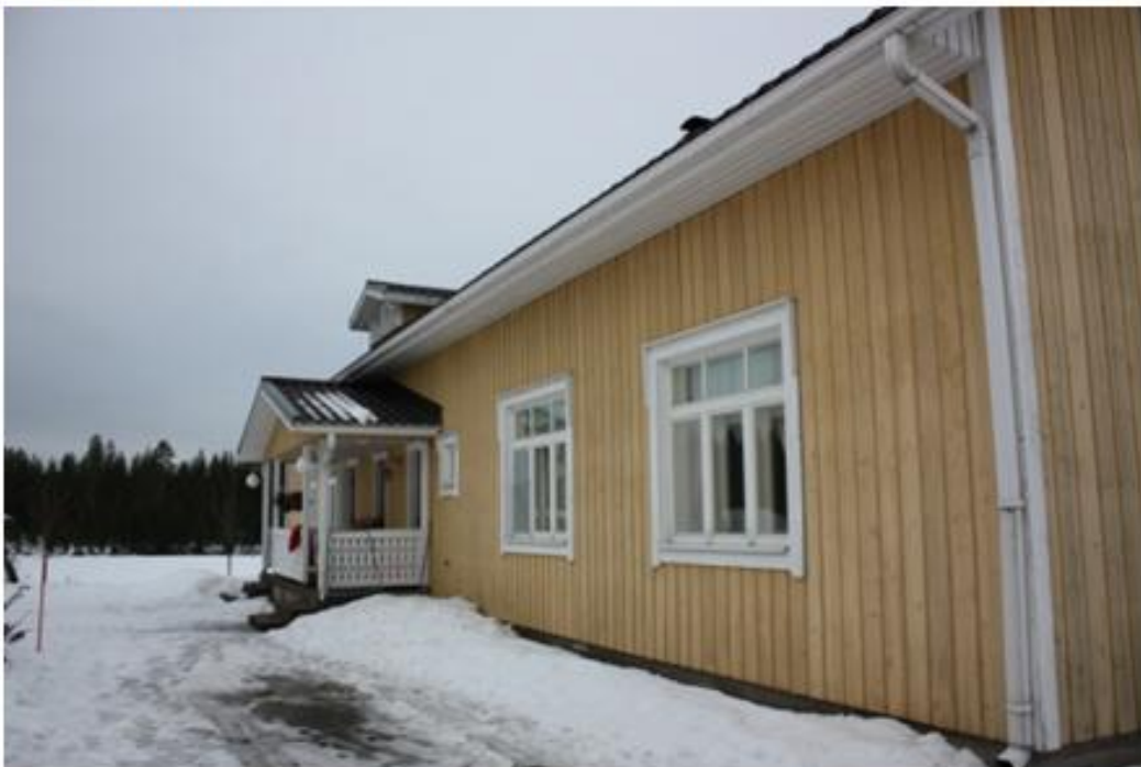
KUVA 7. Rakennuksen julkisivua etupihan puolelta (Siikanen 2015.)
