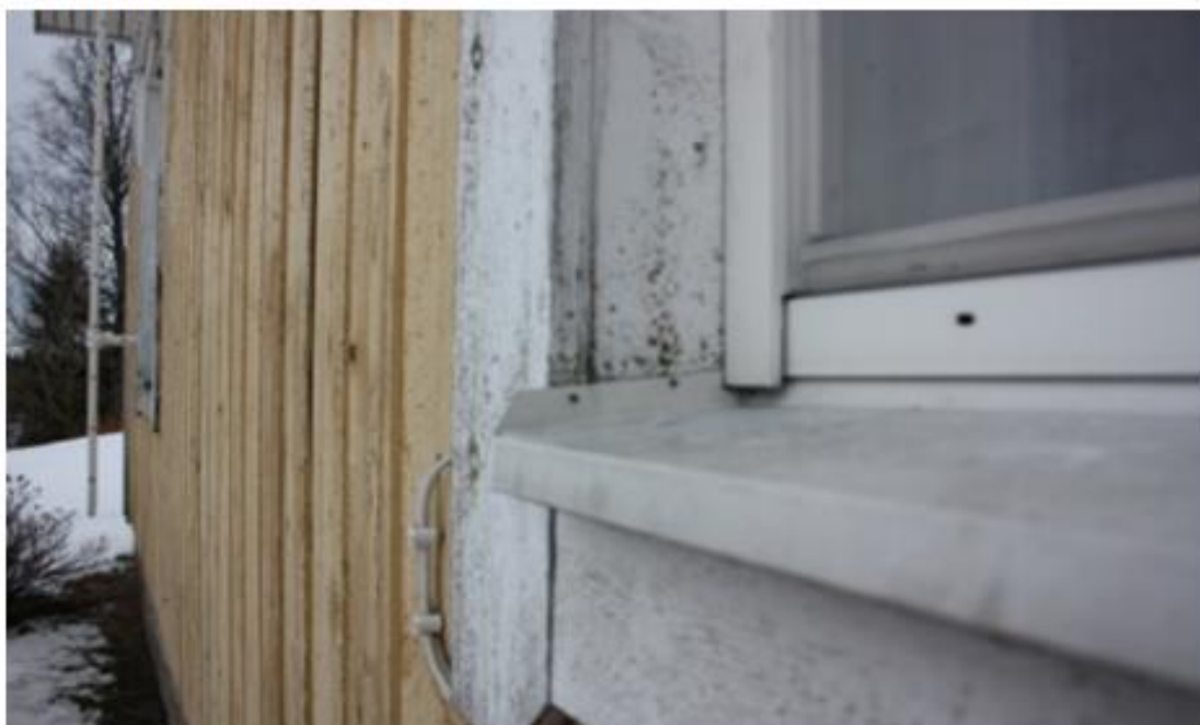
KUVA 12. Ikkunan vesipellitys (Siikanen 2015.)
