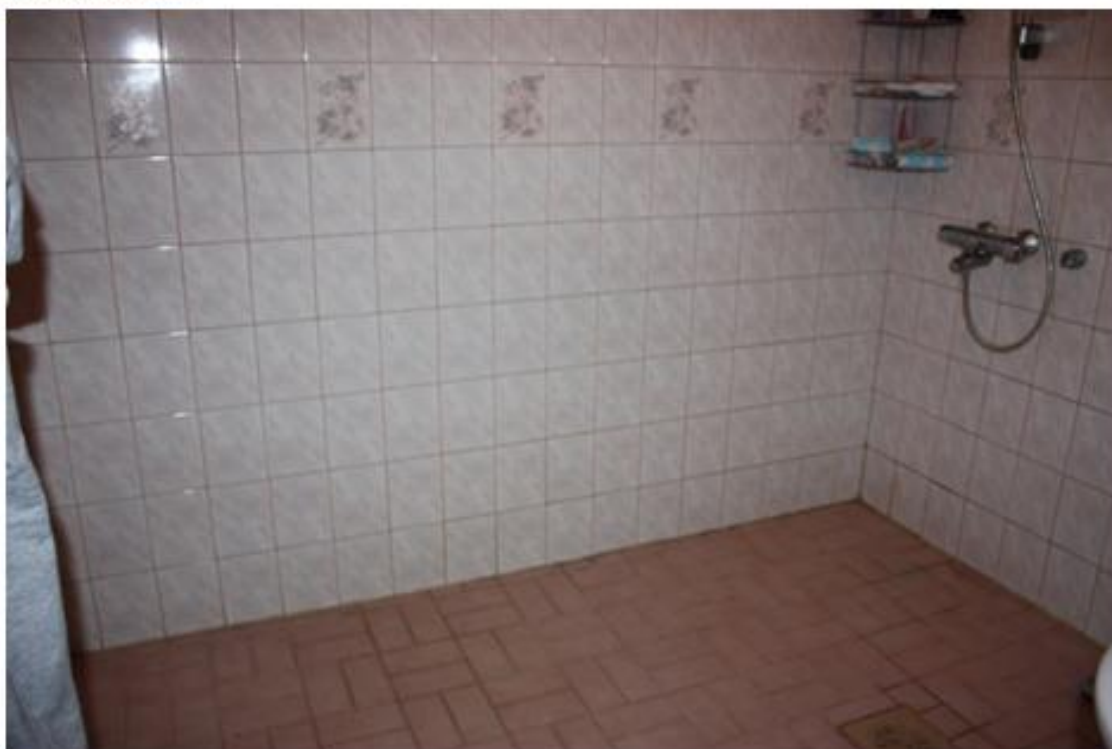
KUVA 22. Huoneisto 1:n kylpyhuoneen pinnat (Siikanen 2015.)
