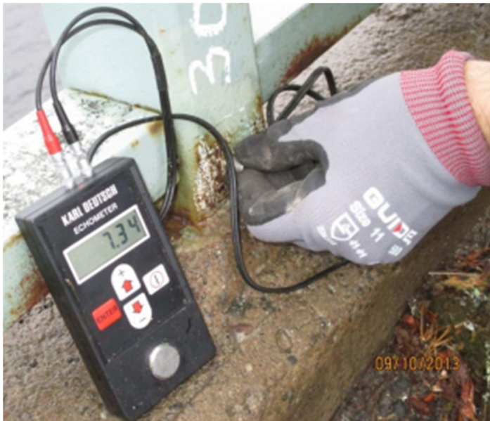
Kuvio 23. Kaidepylvään seinämän paksuuden mittausta ultraäänimittarilla. (Harju 2013)
