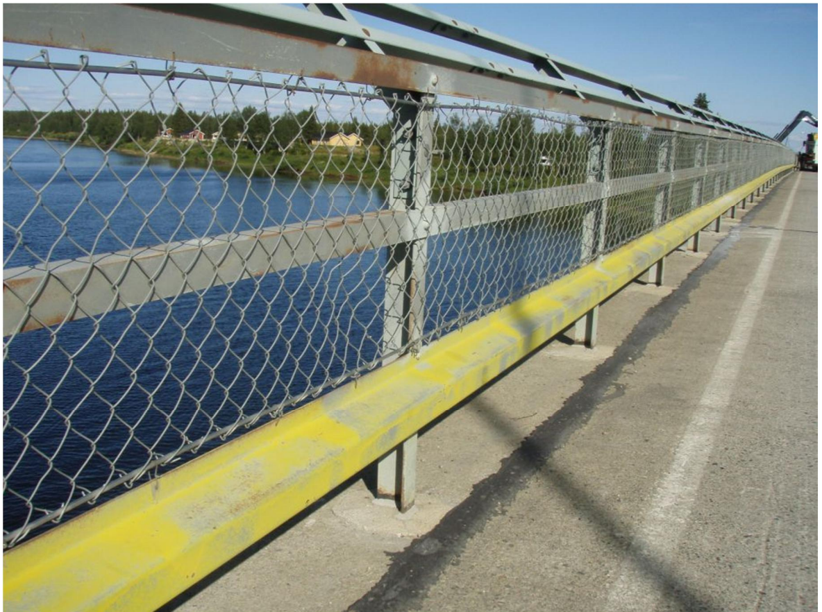
Kuvio 4 Uppokiinnitetty kulmateräsprofiilista niittiliitoksin tehty sillankaide Ounasjo- en salmen sillalla. (Siltakuvat 2015)
