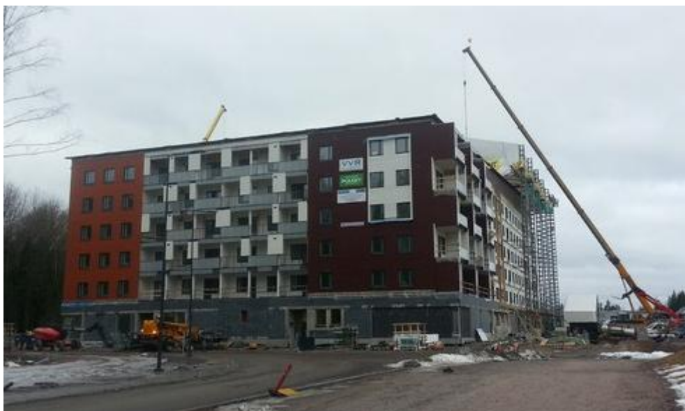
KUVA 2. Puumera Kivistö työmaa (Puumera.fi)
