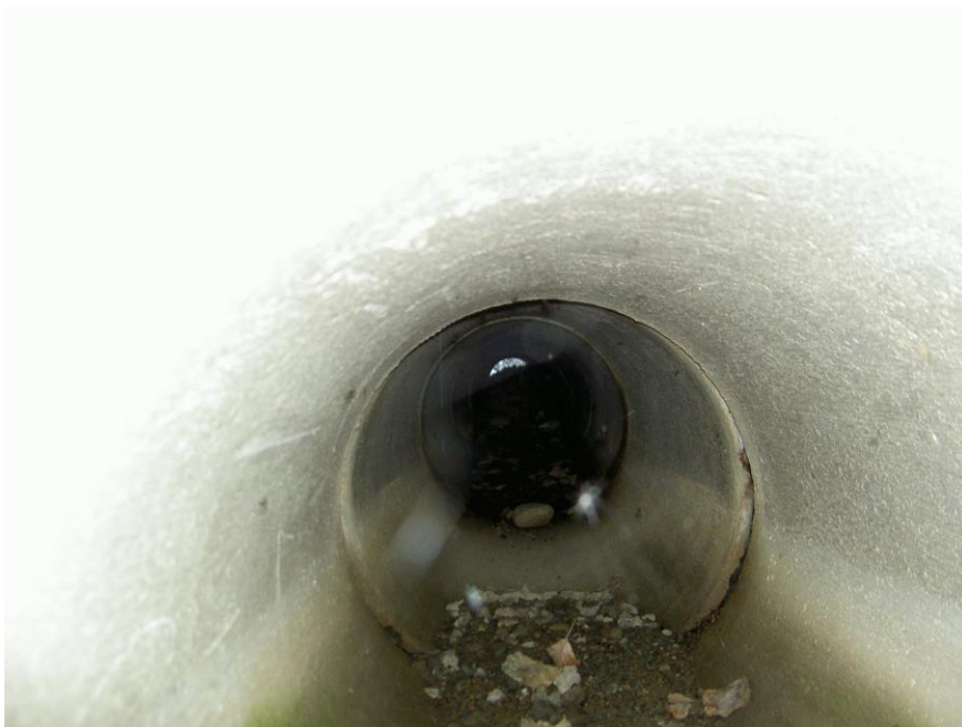
KUVA 5. Paalutuksen suunnassa oleva 1. tierumpu (Olli Halme 2014)
