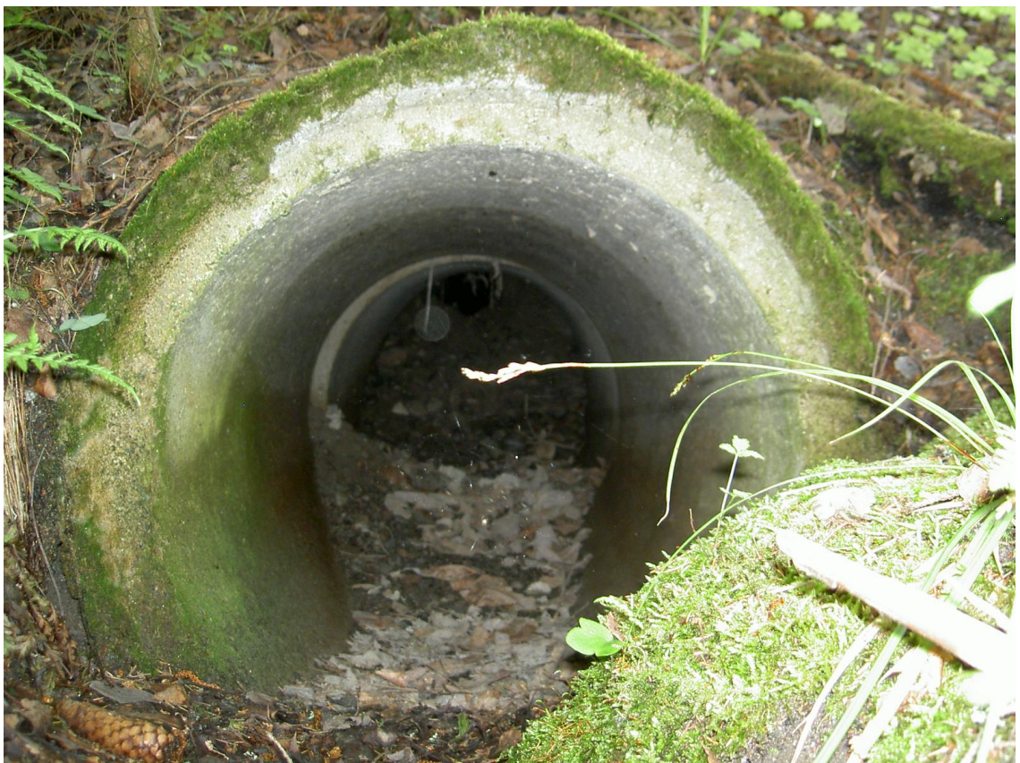
KUVA 7. Paalutuksen suunnassa oleva 3. tierumpu (Olli Halme 2014)
