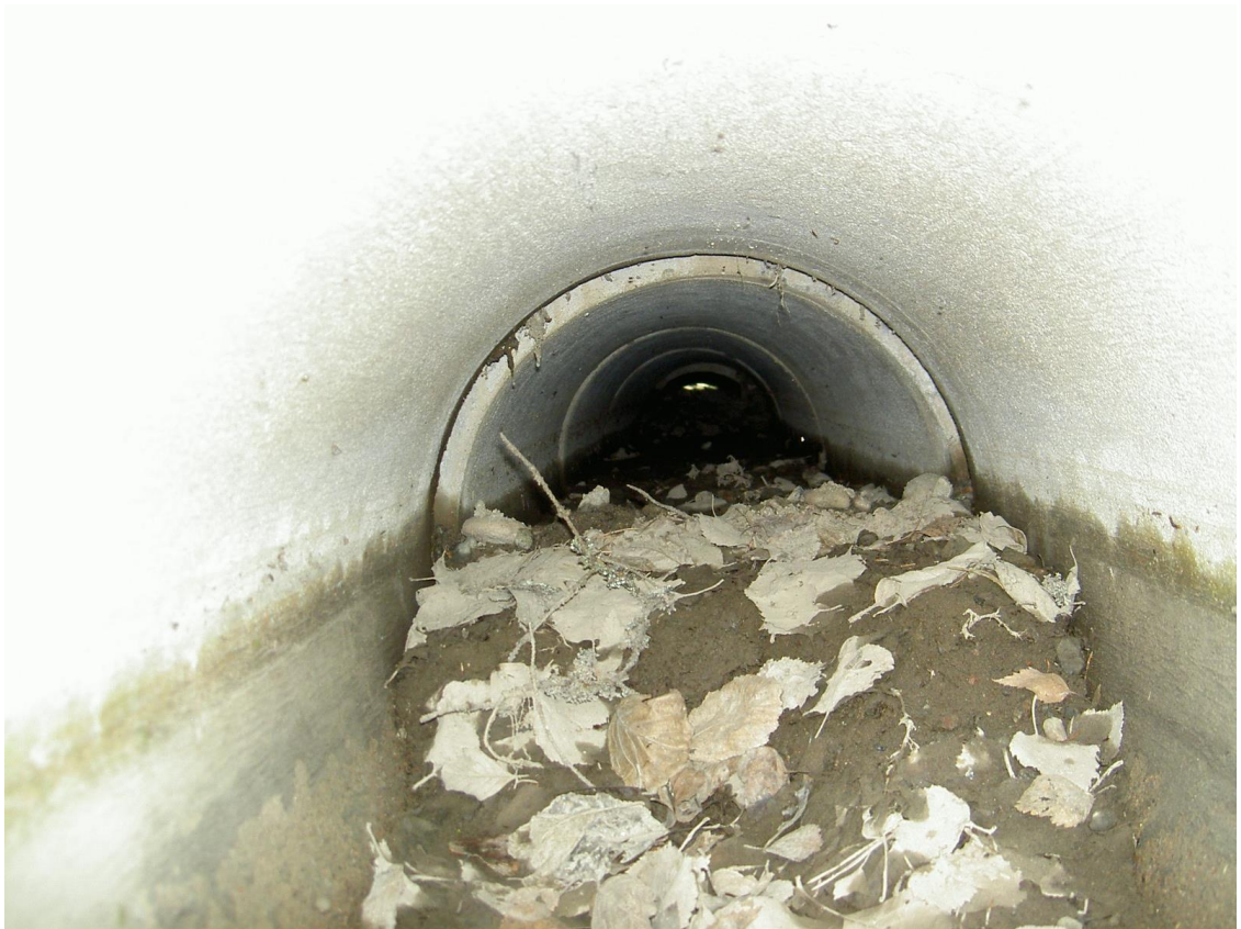
KUVA 6. Paalutuksen suunnassa oleva 2. tierumpu (Olli Halme 2014)
