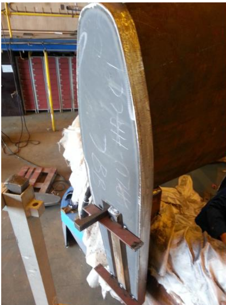
Kuva 9. Päätylevy kiinnitetään suulakkeeseen ja evään väliakaisilla teräslevyillä.
