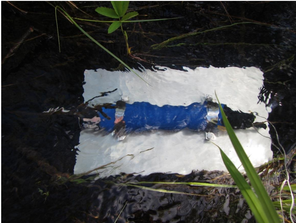
KUVA 8. YSI EXO2 -mittalaite asennettuna kuivatusvesien purku-uoman pohjalle.
