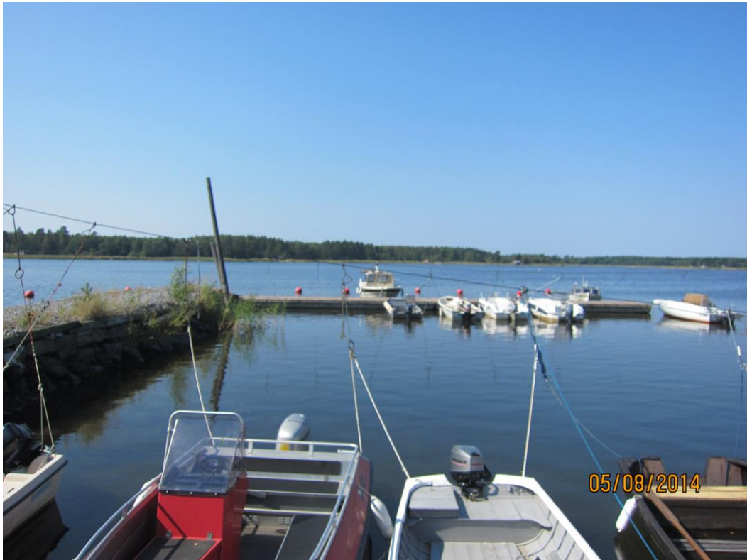
Kuva 4. Ilmavajerikiinnitys Vaasan Västeröverin venesatamassa.
