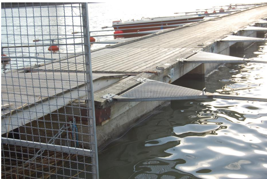
Kuva 8. Betoniponttonilaituri Vaasan Järvikadun pienvenesatamassa.
