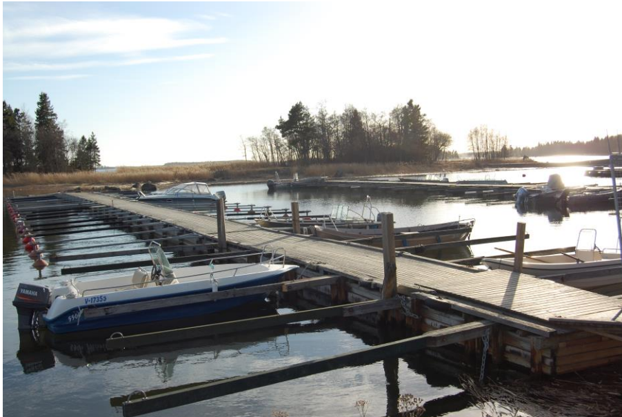
Kuva 7. Lyöntipaalulaituri Vaasan Isolahden venesatamassa.
