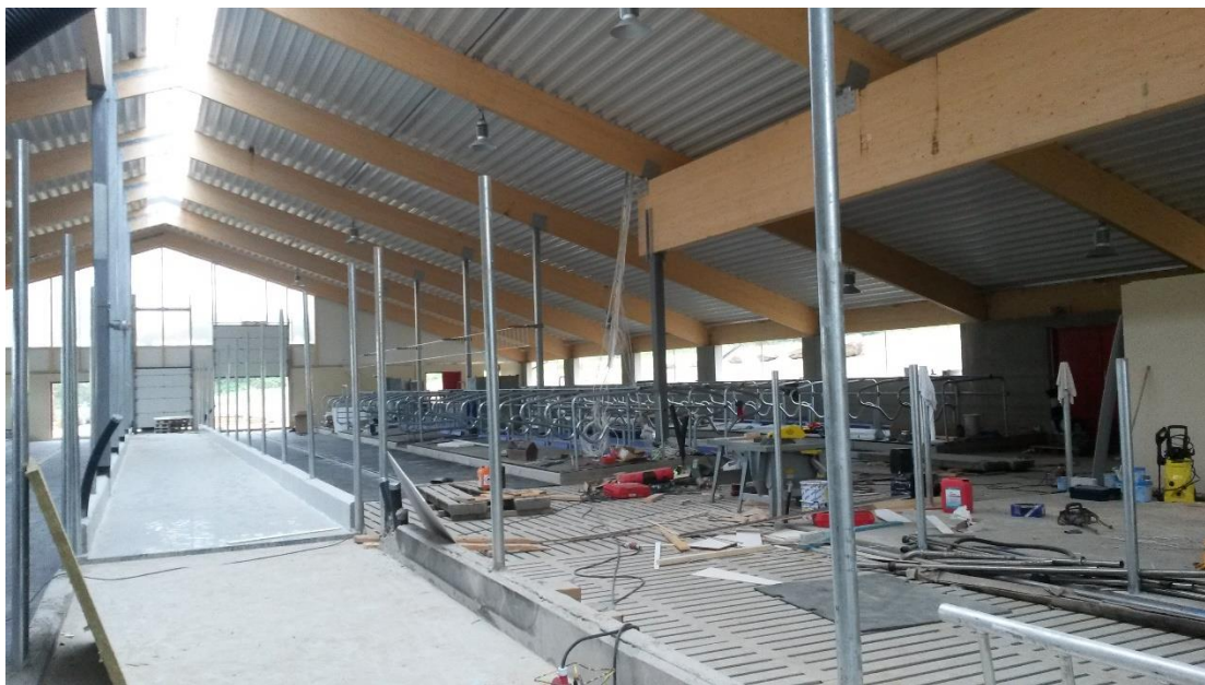
KUVA 4. Hyvät johtamis- ja organisointitaidot ovat tarpeen muun muassa uuden rakennushankkeen töiden hallinnoinnissa (Tiitinen 2014).
