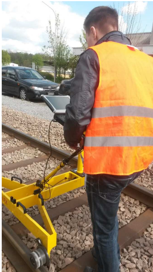
Kuva 2. Mittaamista ratamittausvaunulla käyttäen GPR 1000 -kokoonpanoa.
