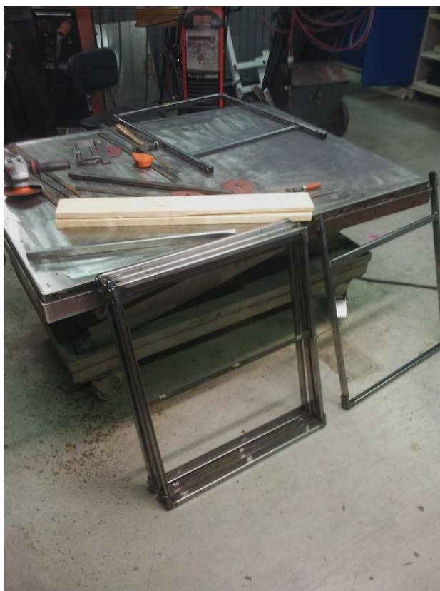
Kuva 12. Hyllyrunkojen valmistelua hitsaamossa.
