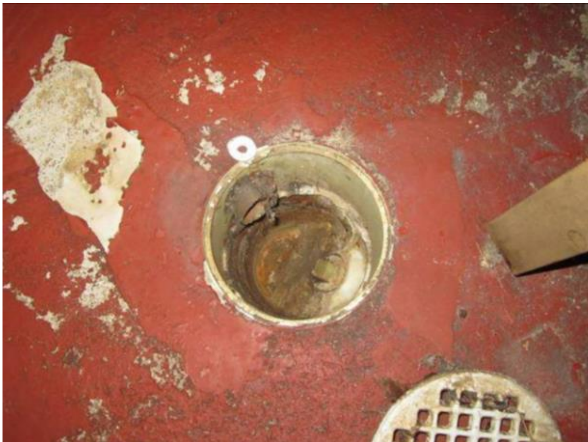
Kuva 19. Saunan lattiapintaa kaivon ympärillä (Miettinen 2014)
