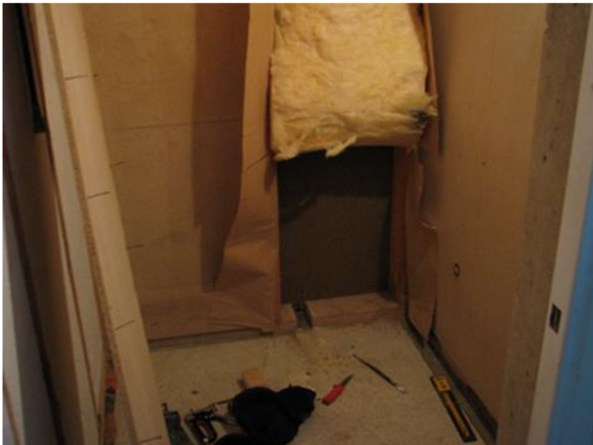
Kuva 29. Avattua ulkoseinärunkoa (Miettinen 2014)
