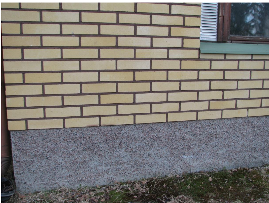
Kuva 2. Kivirouheella pinnoitettu sokkeli ja valesokkeli (Miettinen 2015)
