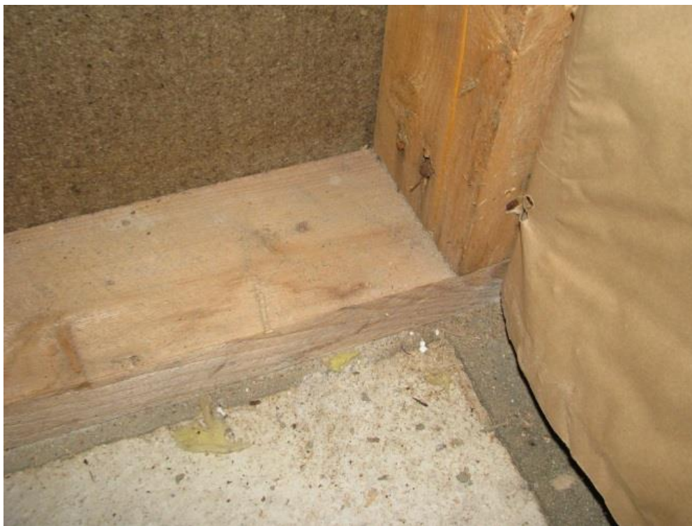
Kuva 31. Ulkoseinän aluspuu esillä (Miettinen 2014)
