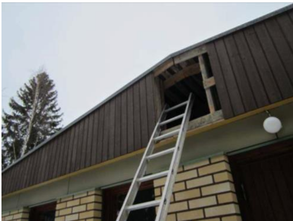
Kuva 46. Ullakon sisäänkäyntiluukku (Miettinen 2014)
