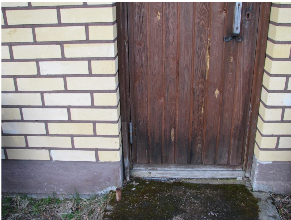
Kuva 49. Teknisen tilan sisäänkäynti (Miettinen 2014)
