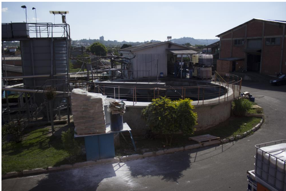
Kuva 32. Vedenpuhdistusjärjestelmä (Kuva: Christiano Tonatto)
