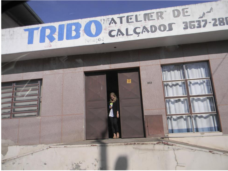
Kuva 2. Tribon julkisivu ja sisäänkänti
