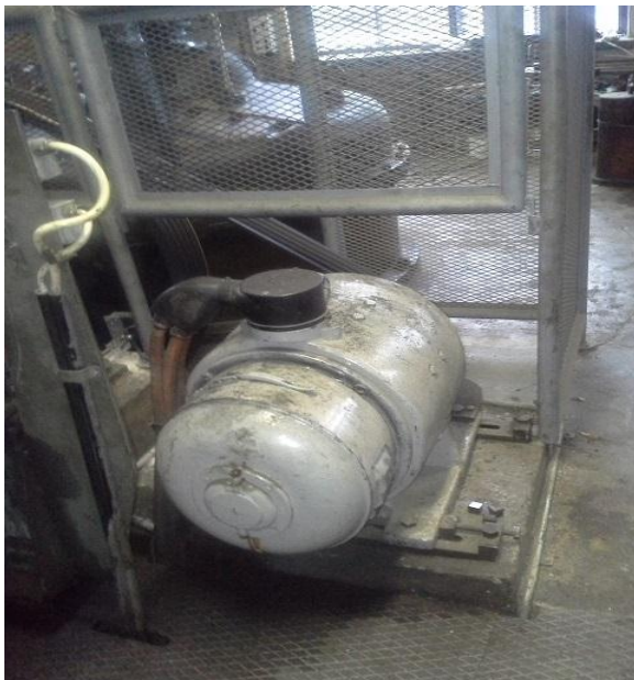
KUVA 1. Generaattorin 3 herätegeneraattori.
