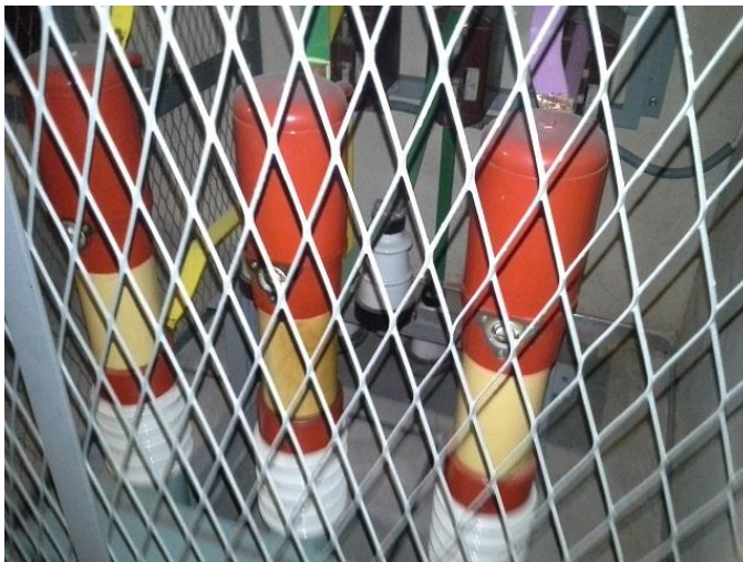
KUVA 3. OSAP 20-W2 -suurjännitekytkin.
