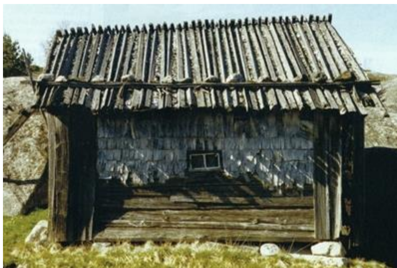
Kuva 2. Malkakattoinen ulkorakennus (Vanhan talon historia ja hoito 2011, 76).
