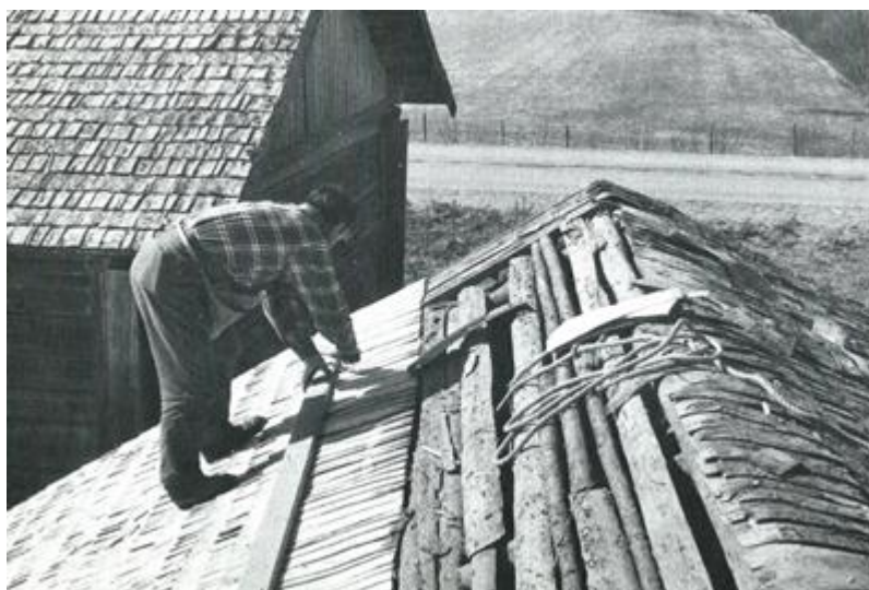
Kuva 8. Pärekaton tekoa. Apuna käytetään linjalautaa (Härö & Kaila 1976, 116).
