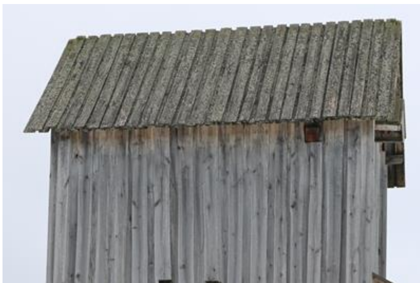
Kuva 4. Lomalaudoitettu tuulimyllyn lautakate Siilinjärven Kasurilassa.
