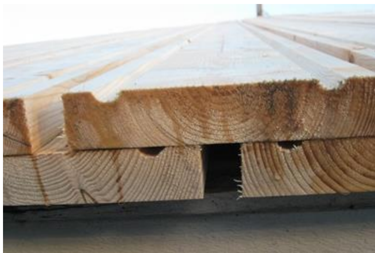
Kuva 12. Sydänpuolelta uritettua lomalaudoitusta.
