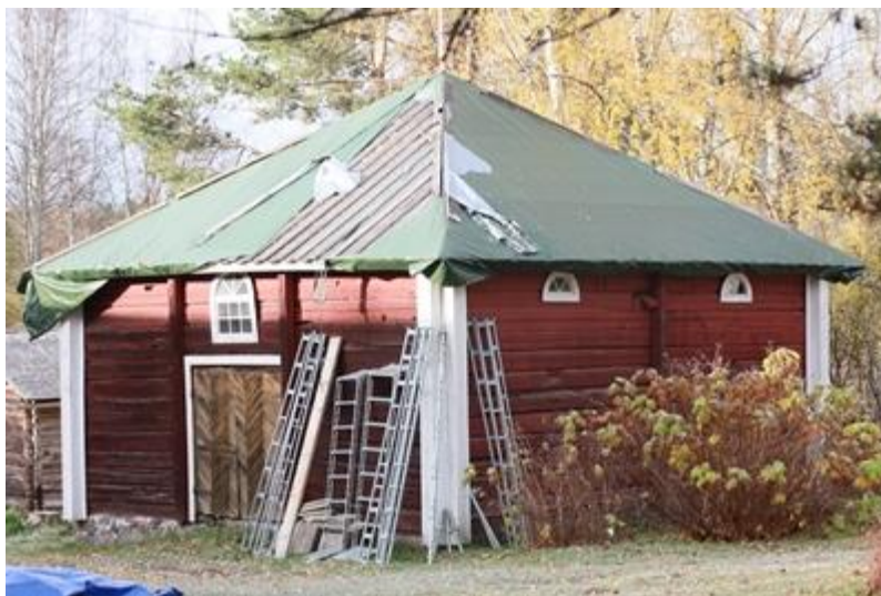
Kuva 9. Kirkkotalli ennen katteen uusimista.
