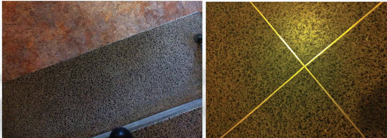
Kivilattia messinkisaumoin sisääntulossa ja hissiaulassa
