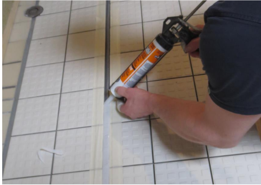
Kuva 30. Saumamassa pursotettiin tiiviisti liikuntasamaan.
