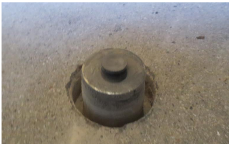
Kuva 36. Alustabetoniin liimattu vetokoekiekkok.
