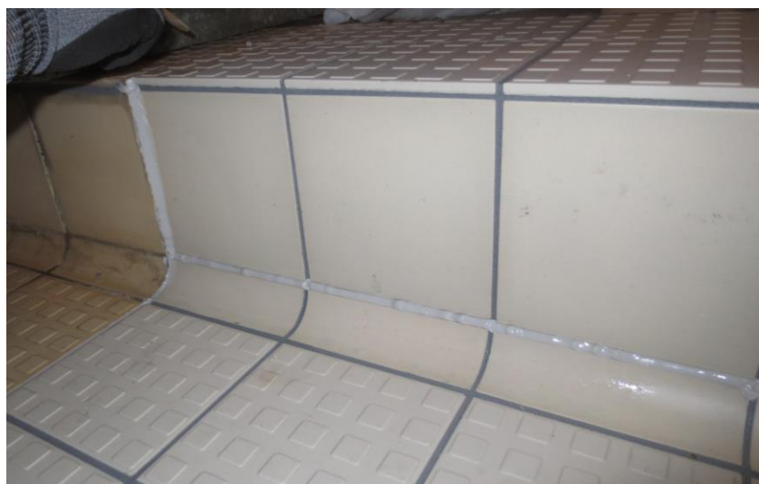
Kuva 29. Saumaan pursotettu silikoni ennen tasoitusta.
