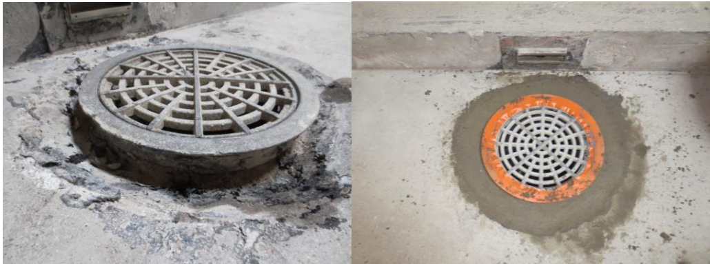
Kuva 22. Kaivon ympärille tehty valukorjaus.
