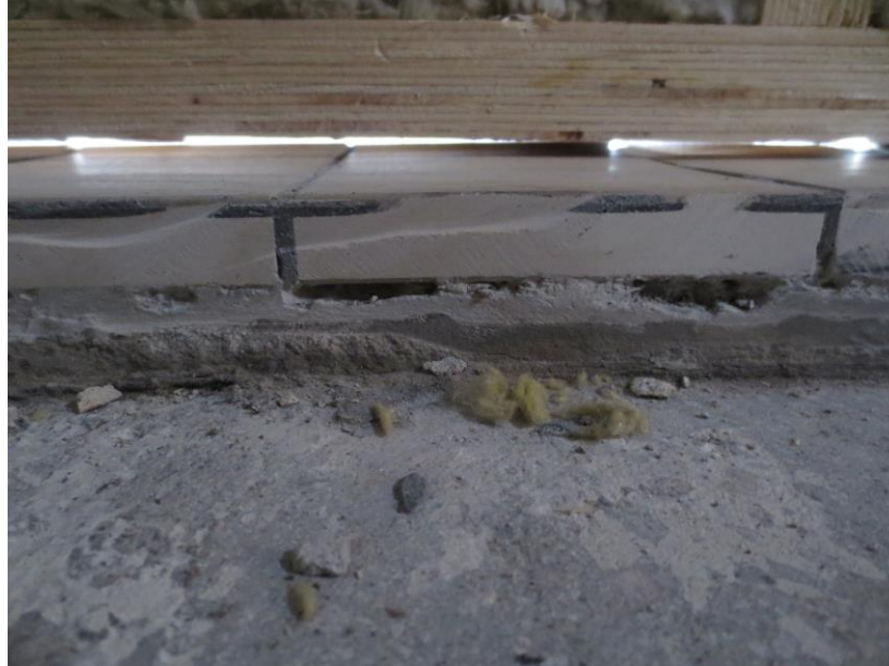
Kuva 21. Purkutyöt rajattiin altaanpuoleisella reunalla allasreunalaattoihin. Laatan alla on nähtävissä vielä lujuudeltaan heikon tasoitteen ja kiinnityslaastin muodostama kerros, joka reunalaattojen säästämiseksi oli kuitenkin jätettävä paikoilleen.
