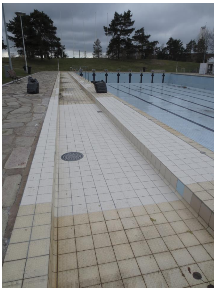
Kuva 48. Tämän työn tuloksena valmistunut testikenttä, jonka alueella käytettyjen järjestelmien toimivuutta voidaan tarkastella tulevina vuosina.
