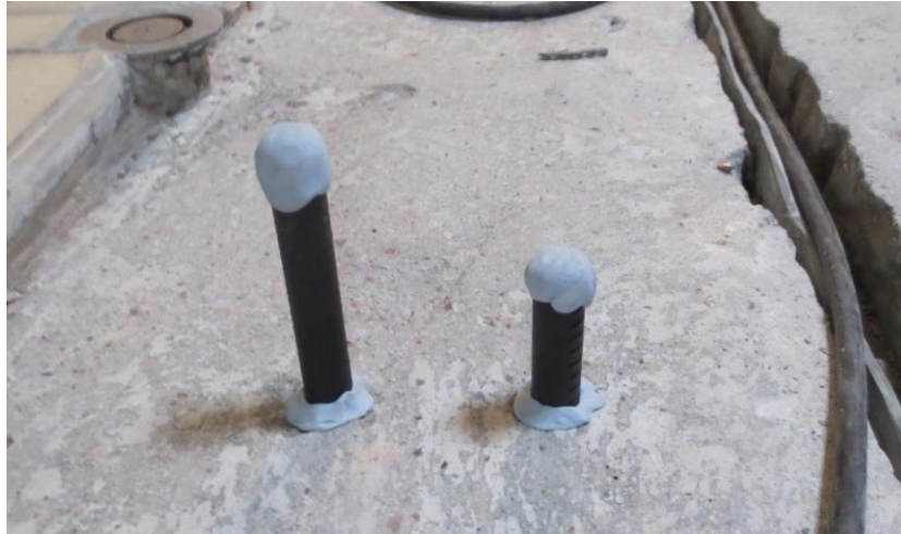
Kuva 40. Kuva. Porareikiin asennetut ja tiivistetyt putket.
