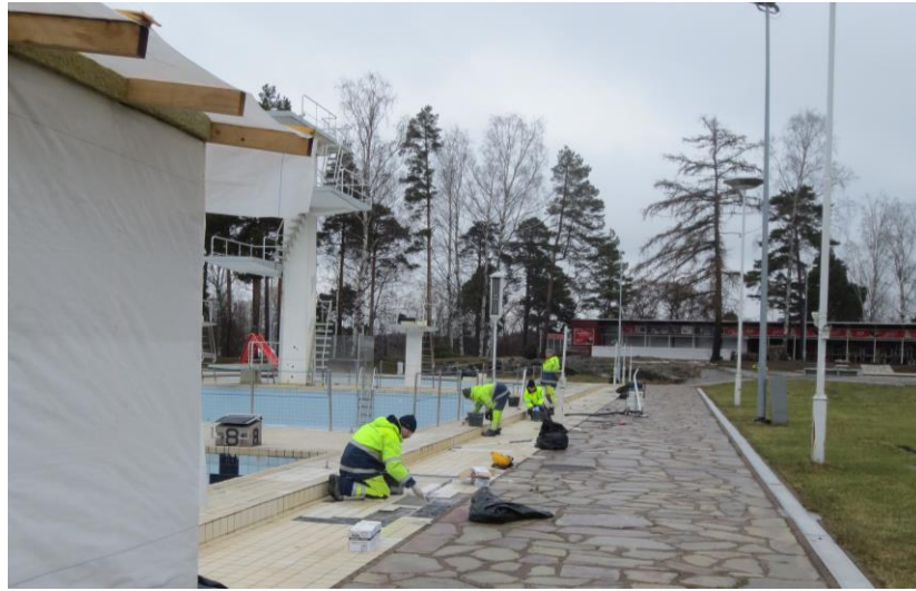
Kuva 12. Laatoitus- ja saumaustyöt käynnissä Uimastadionilla 1.4.2015. Ilman lämpötila oli kuvaushetkellä 2,5 °C ja betonialustan lämpötila -0,8 °C. Myöhemmin päivällä alkoi sataa.
