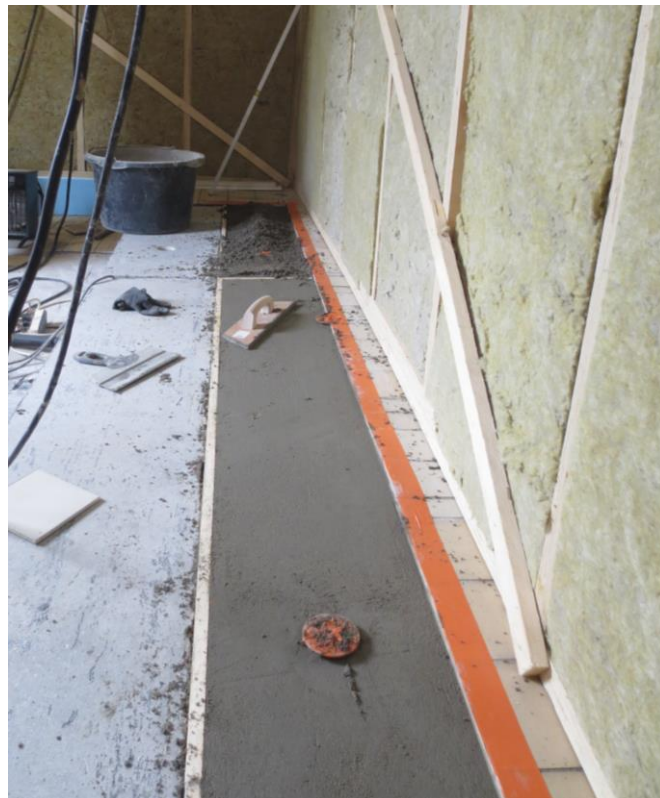
Kuva 23. Uloimman elementin korotus valukorjauksella. Liikuntasaumoihin asetettiin puurimat valuohjureiksi. Betonipinnat viimeisteltiin hiertämällä.
