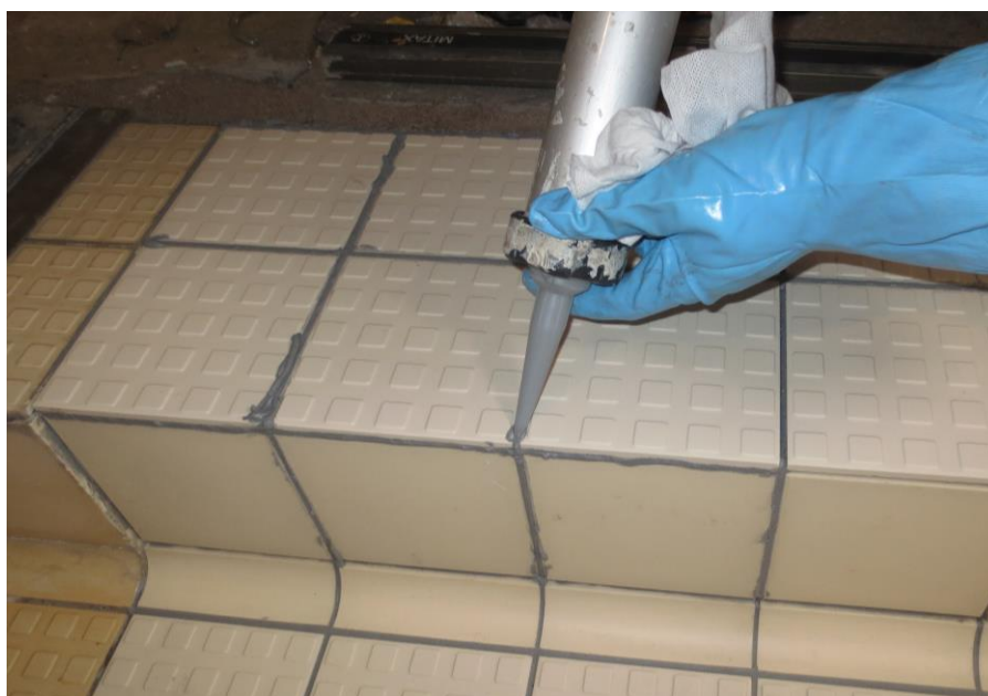
Kuva 28. Epoksisauoma pursotettiin massapuristimella suoraan laattasaumoihin, ettei epoksi pääsisi palamaan nappulalaatan pintaan.
