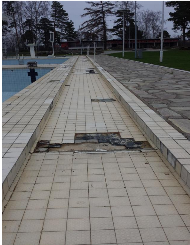
Kuva 15. Yleiskuva korjattavasta alueesta.
