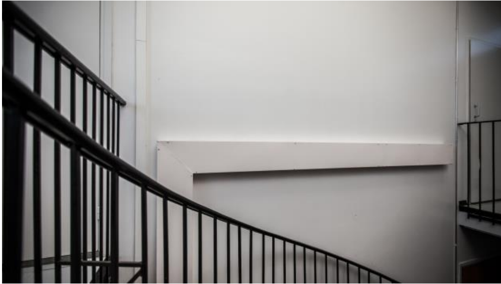
Kuva 12. Lämmönkeruuputkisto asennettuna porraskäytävään
