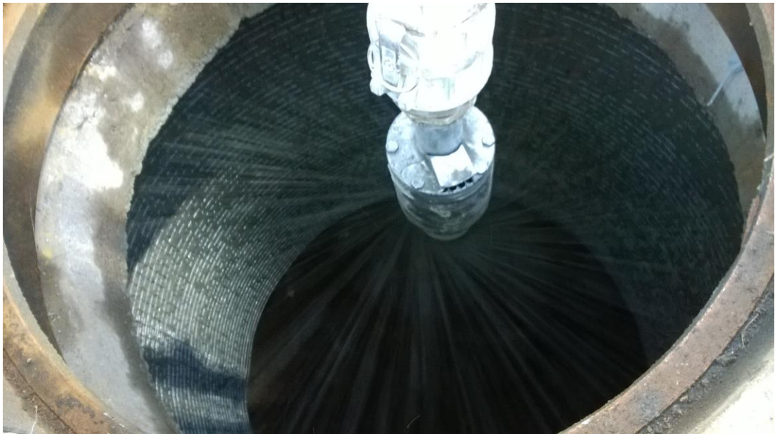
Kuva 8. Viemärikaivon laastiruiskutusta (kuva: Kallio 2014).
