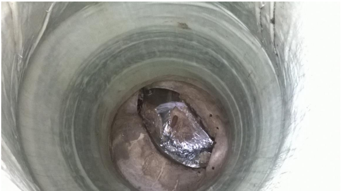
Kuva 6. Lasikuitukaivo asennettuna vanhan betonikaivon sisään (kuva: Kallio 2014).
