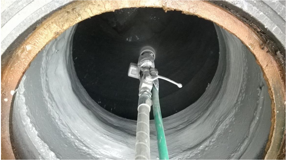
Kuva 9. Jätevesikaivon pinnoitusta (kuva: Kallio 2014).
