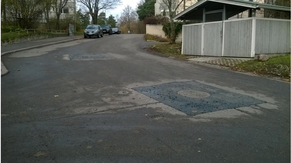
Kuva 7. Saneerattuja viemärikaivoja Helsingissä (kuva: Kallio 2014).
