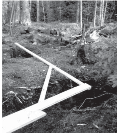
Mökin paikka määriteltiin suorakulmalla, linjalaudoilla ja ristimitoilla.
