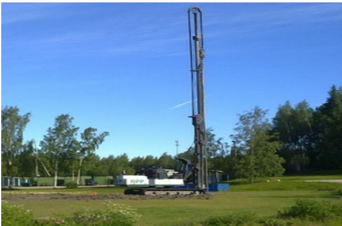
Kuva 3. Stabilointikone (Rakentajat Piippo & Pakarinen, 2014).
