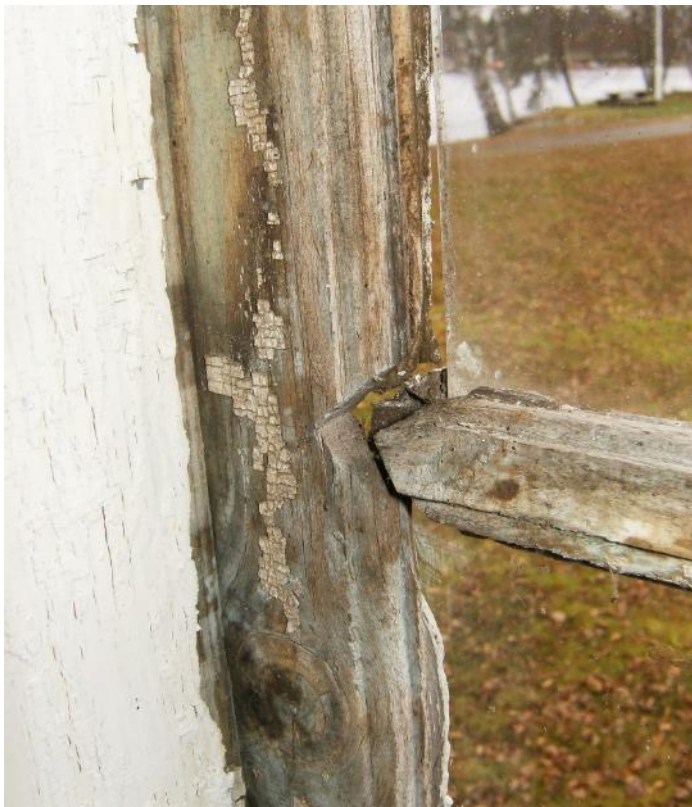
Kuva 26 Jämsänkosken kotiseutumuseon Aarresaaren päärakennuksen ikkunat ovat päässeet huonoon kuntoon, mutta ovat silti täysin kunnostettavissa.
