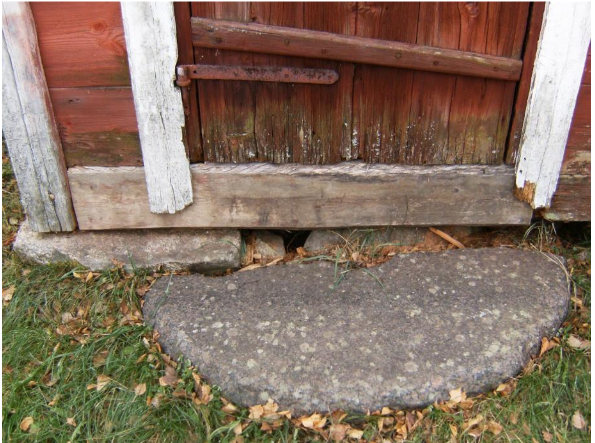
Kuva 16 Jämsänkosken Aarresaaren kotiseutumuseon tehdastyöläisen mökin porraskiveltä on roiskunut sadevesi seinälle. Alin hirsi on jouduttu joskus vaihtamaan.
