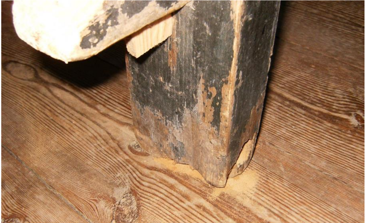
Kuva 21 Keuruun kotiseutumuseon päärakennuksessa olevien kangaspuiden jalan juuresta on löytynyt purua.
