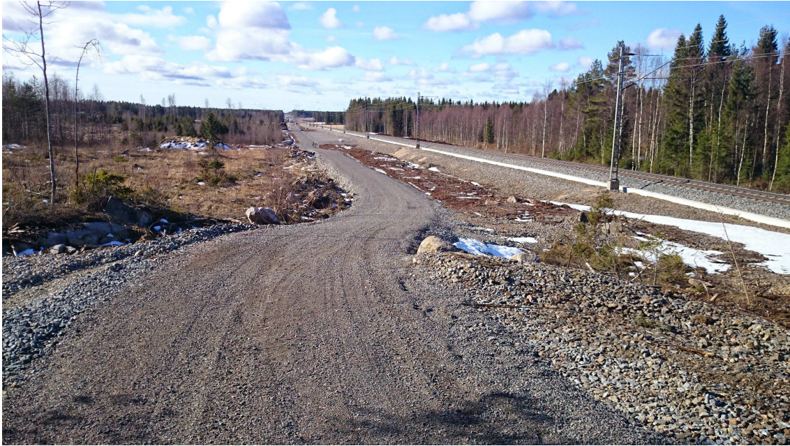
KUVA 18. Huoltotien lopullinen sijainti muodostui vasta maastossa rakentamisvaiheessa
