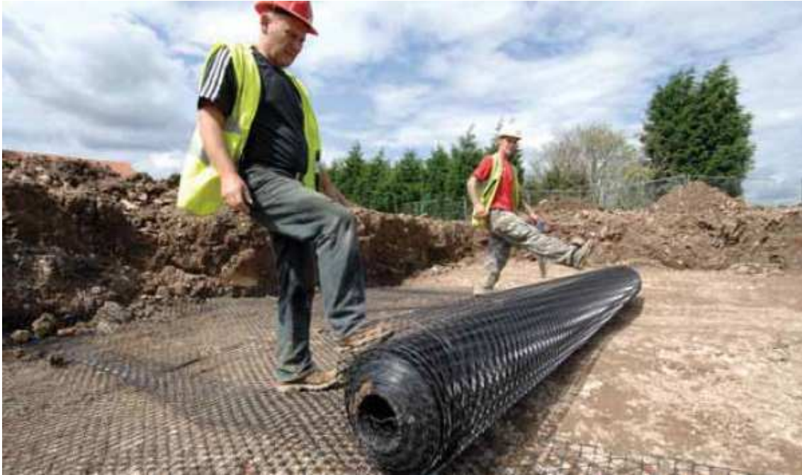
KUVA 8. Lujiteverkon asennusta maastossa (10, s. 3)
