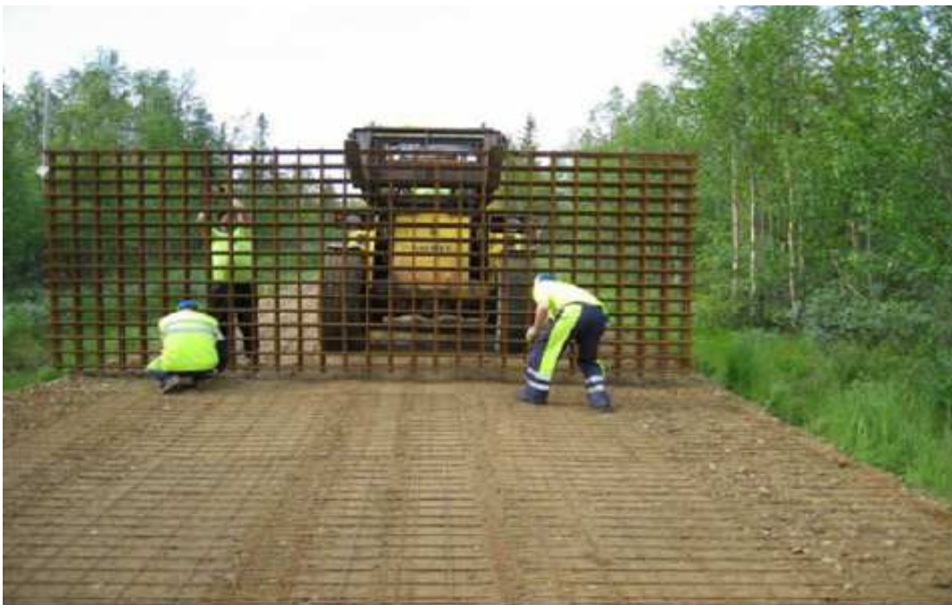
KUVA 11. Teräsverkon asennusta työmaalla (13)
