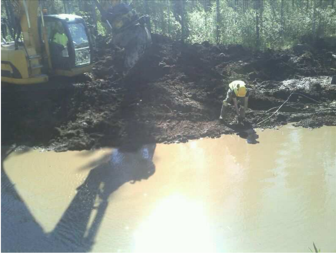
KUVA 13. Kaivinkone ja lapiomies työskentelemässä kaapelinsiirrossa työmaalla Oulainen - Kilpua
