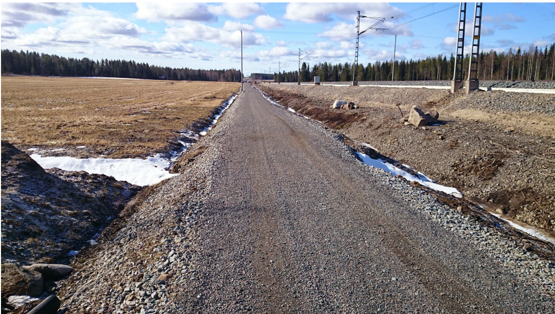
KUVA 15. Valmista huoltotietä viimeistelytyöiden jälkeen
