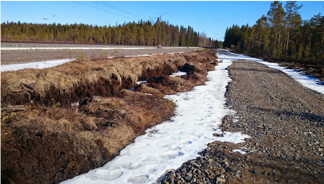
KUVA 17. Huoltotien painuessa syrjäytetty maa nousi vierestä huomattavasti
