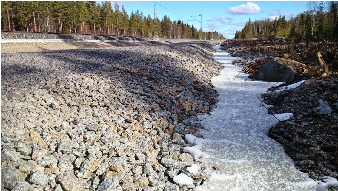
KUVA 16. Tien lopullisesta rakenteesta tuli paljon suunniteltua paksumpi pehmeiköillä
