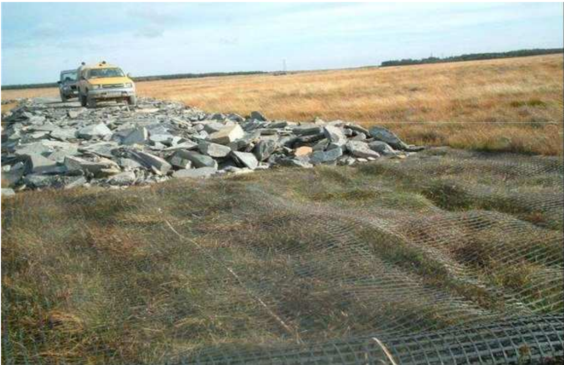
KUVA 7. Lujiteverkko levitettynä pehmeikölle maa-aineksen ajoa varten (9, s. 40)
