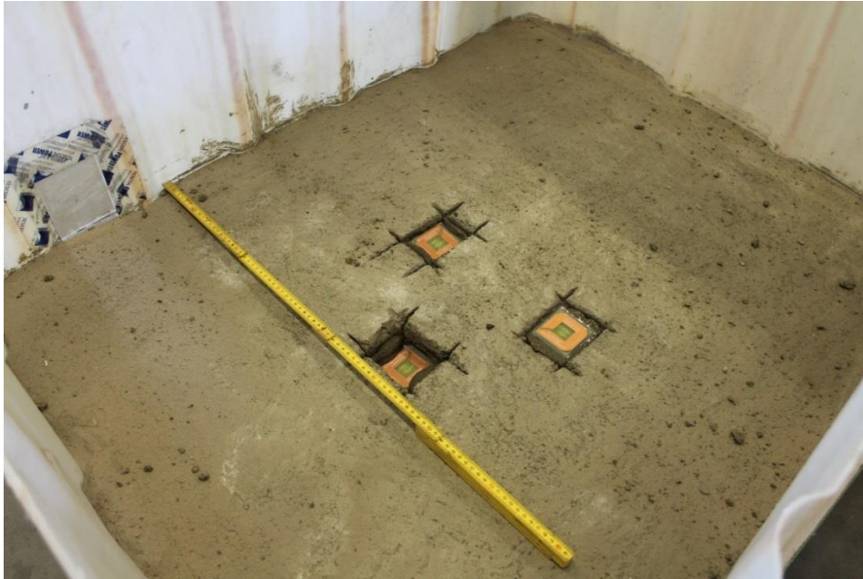
Kuvio 16. Kosteusanturit asennettuina betonivaluun.
