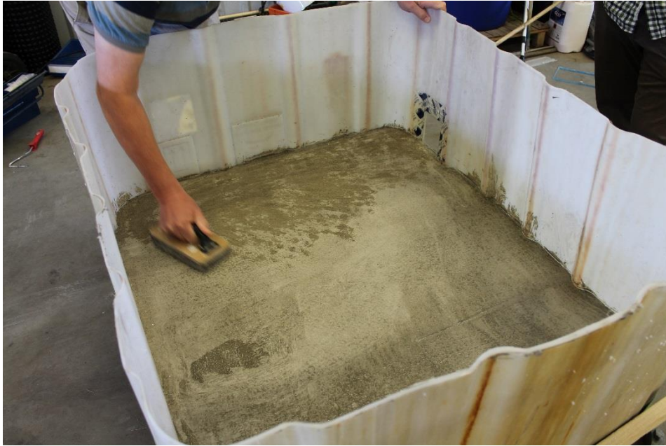
Kuvio 15. Sementtiliiman poisto betonilaatan pinnasta.
