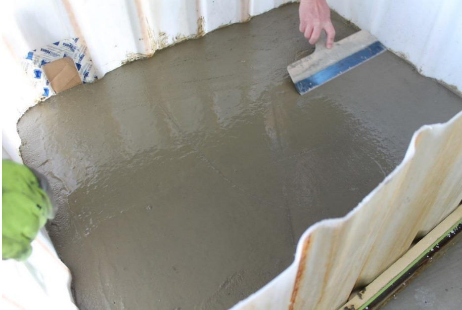
Kuvio 14. Betonivalun viimeistely.
