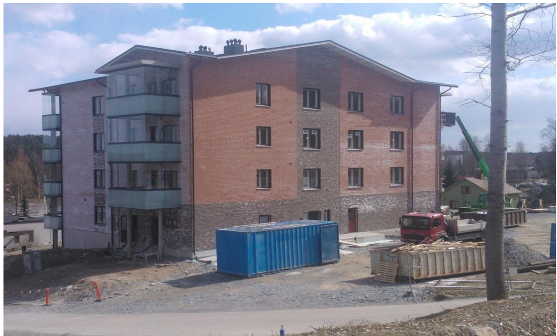
Kuvio 7 Kurkiranta I rakennustyömaa keväällä 2014
