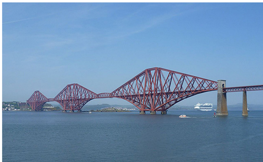
Kuva 5. Firth of Forth rautatiesilta (Railway-technology.)
