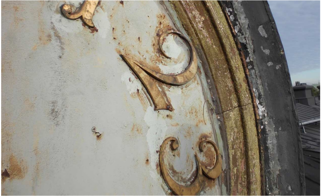
Kuva 45. Messinkipellin alta paljastui puinen ulkokehys. Kuva Kello ja Kultra Widemark.
