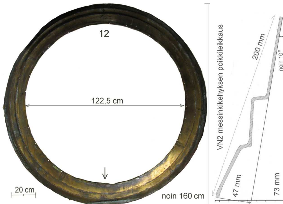
Kuva 48. VN2 puukehysen päällä ollut messinkikehys sisäpuolelta 2010. Alareunassa näkyy seisoneen veden aiheuttama värimuutos = kuparin korroosiotuotteita.
