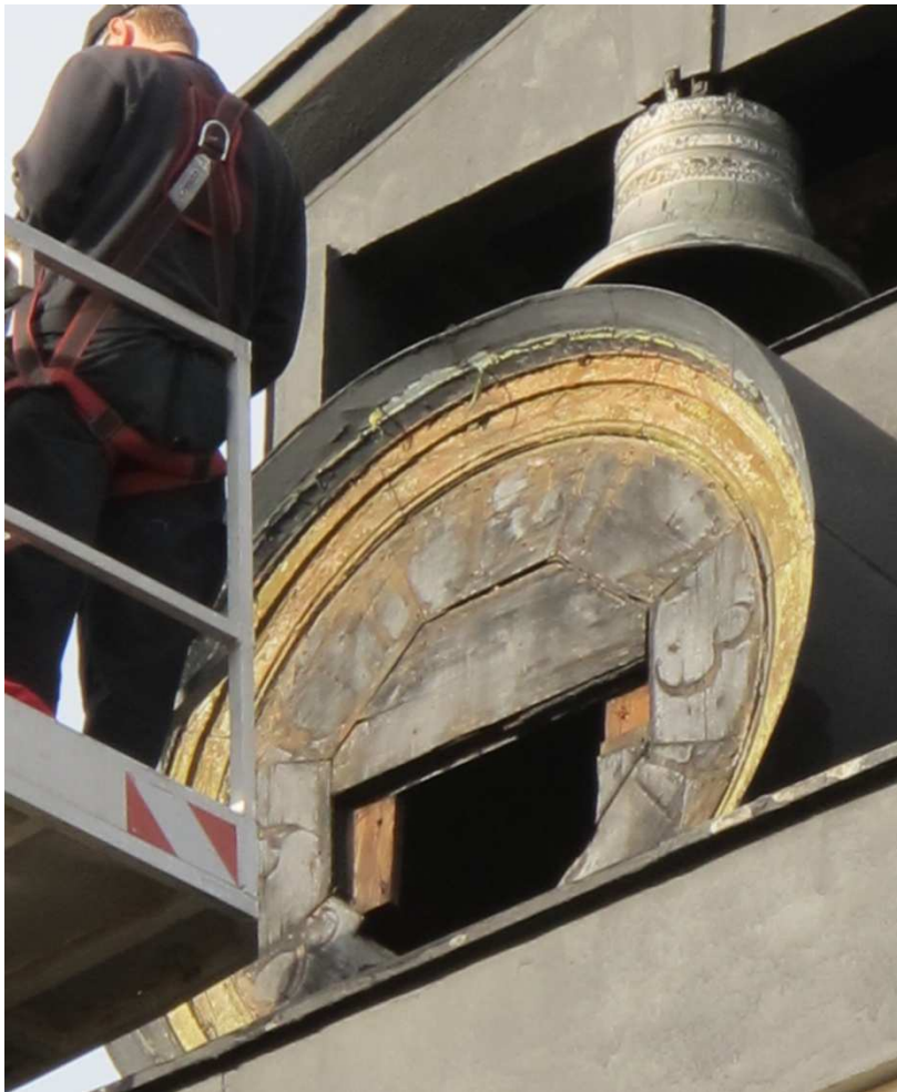
Kuva 46. VN2:n alkuperäinen puinen kellotaulu peltisen poiston jälkeen 7.9.2010. Kuva Ismo Tuovinen, Kello ja Kultra Widemark.
