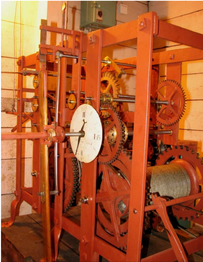
Kuva 41. VN:n tornikellon koneisto restauroinnin jälkeen.
