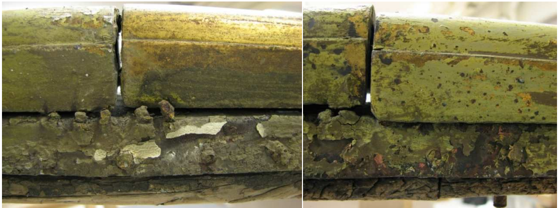
Kuva 9. Lähikuva VN1 ulkokehyksen liitoskohdasta ulkoreunan puolelta 9.11.2010.
