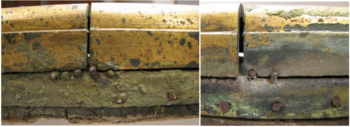
Kuva 7. Lähikuva VN1 ulkokehyksen liitoskohdasta ulkoreunan puolelta 9.11.2010.
