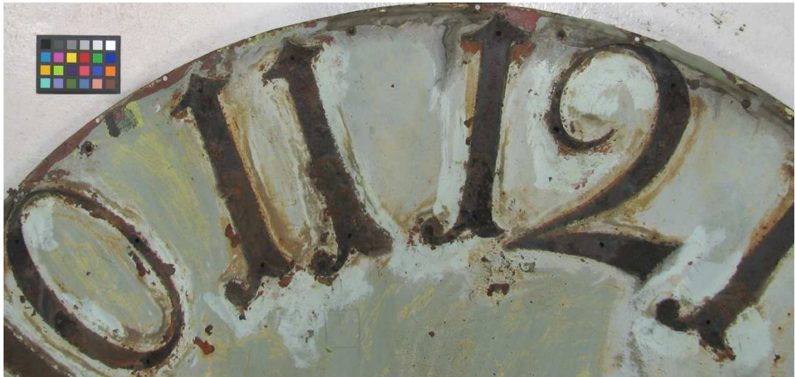
Kuva 62. Yksityiskohta VN2:n peltisestä kellotaulusta 2.12.2010. Viimeinen yhtenäinen vaaleanharmaa (4.) maalikerros oli niin liituuntunut, että se oli pyyhittävä pois kuivalla kankaalla. Viimeiseksi oli sutaistu sinne tänne ruostekohtien päälle vaaleansinistä (5.) maalia.
