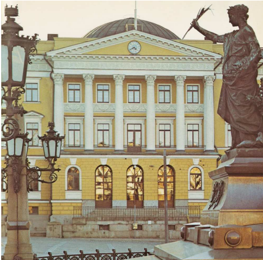
Kuva 18. Kuva s. 23 kirjasta Vanha Helsinki , vuodelta 1979, kuva Markus Leppo (1934–1994). Kellotaulussa on viimeisin vaaleansininen maalikerros, ulkokehys on harmaa ja numeroiden kultaus näyttää uudehkolta.
