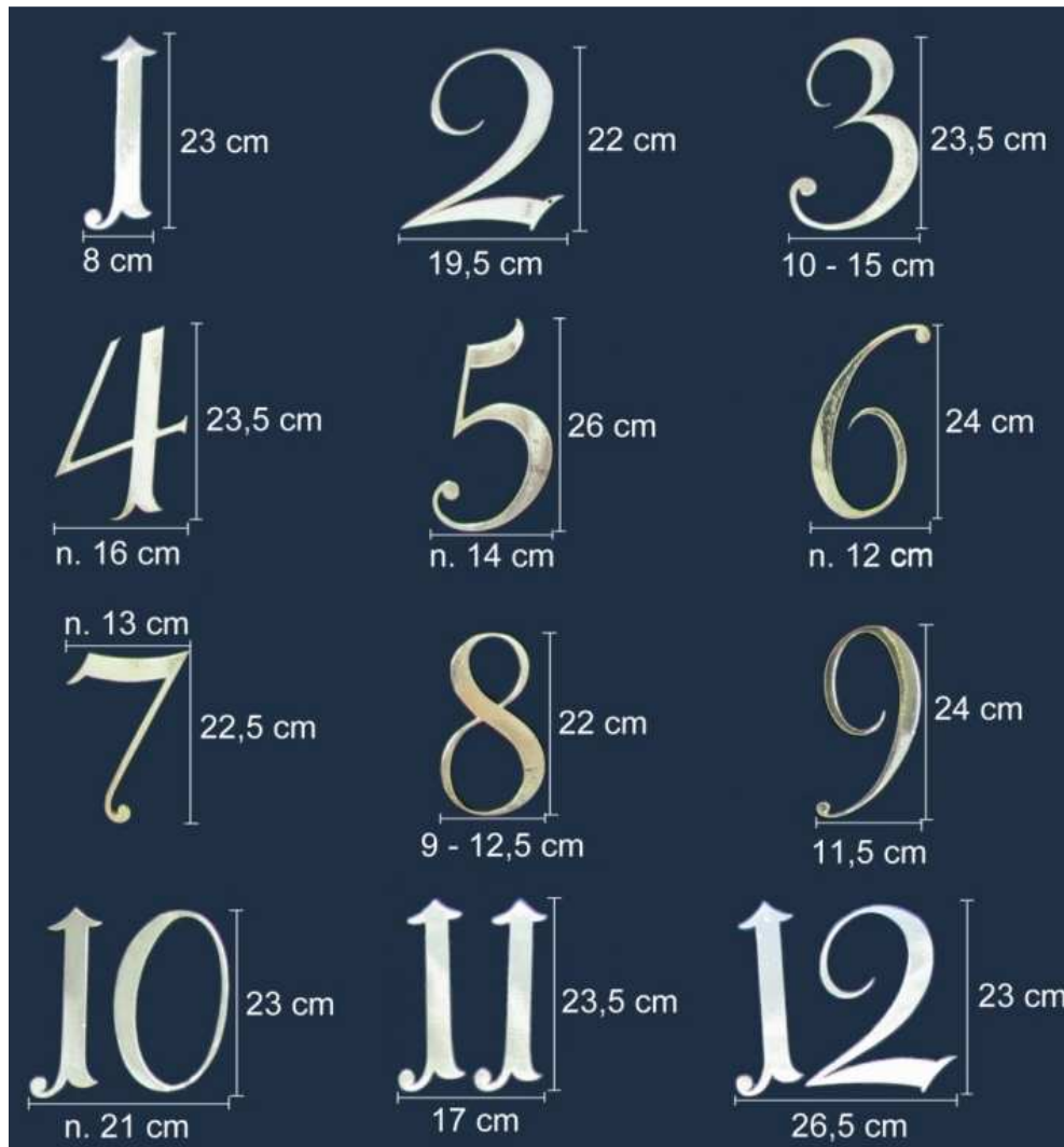
Kuva 79. VN2-kellotaulun numerot uudelleenkullattuina 7.3.2011 mittoineen.
