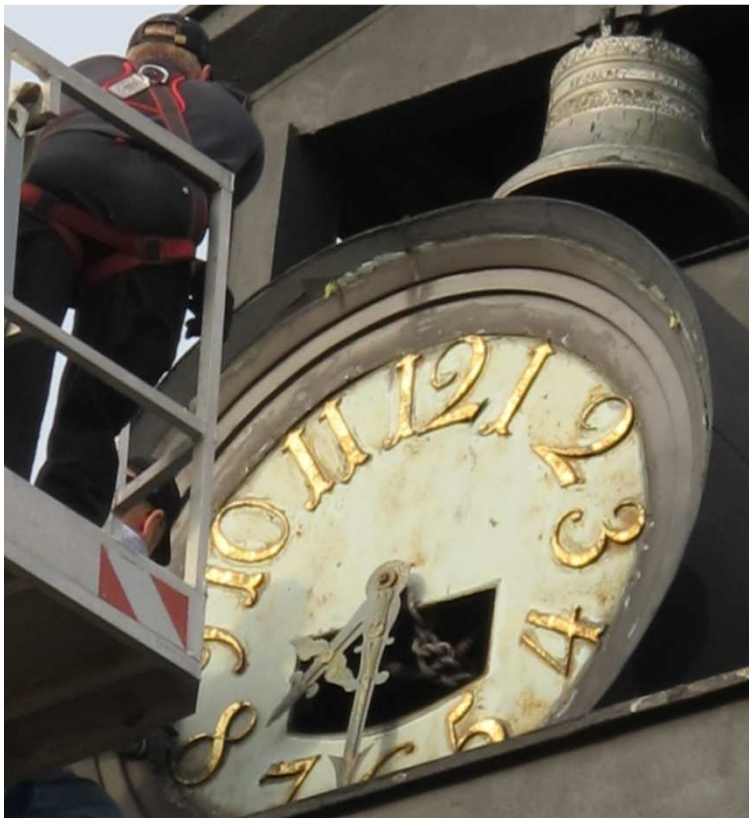
Kuva 44. Tapio Talja irrottaa VN2:n messinkistä ulkokehystä 7.9.2010. Kuva Ismo Tuovinen, Kello ja Kulta Widemark. Uudehko profiloitu messinkipelti peitti puista ulkokehystä. Se oli ruuvattu kiinni puuhun ja saumat oli tiivistetty harmaalla joustavalla massalla.
