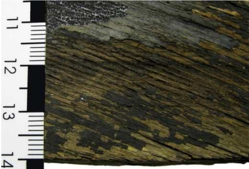
Kuva 58. Lähikuva VN2:n puisesta kellotaulusta 14.3.2011. Mustan maalikerroksen alla näkyy vaaleaa pohjustusta.
