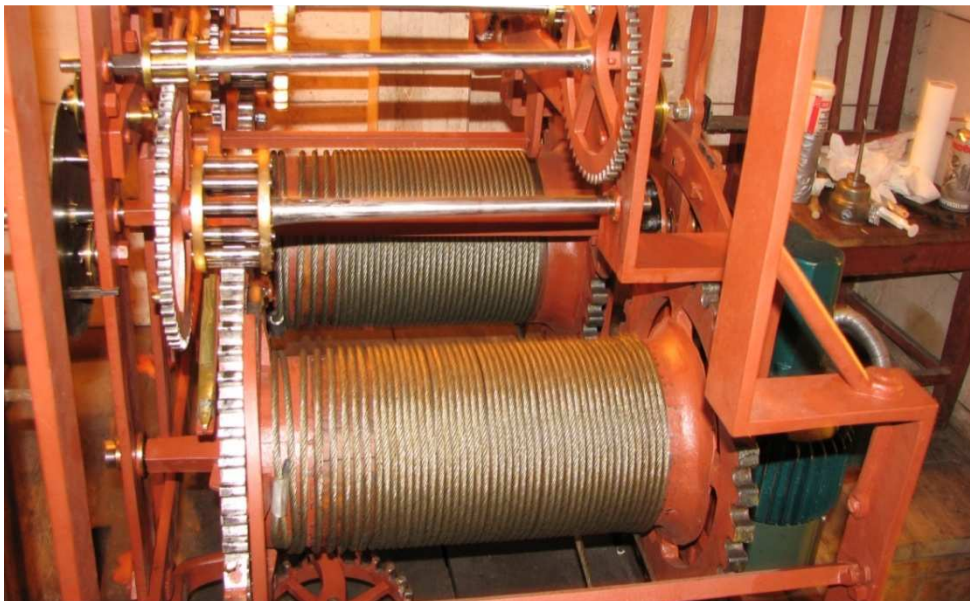
Kuva 42. Uudet painoköydet ovat teräsvaijereita - kuvat Raili Laakso.
