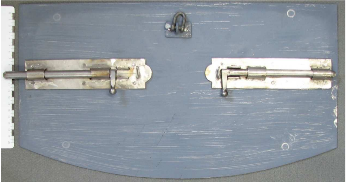
Kuva 72. Taideseppä Mikko Ramsin tekemä uusi VN2-huoltoluukku takaa 14.3.2011. Ylhäällä on uutena ratkaisuna lenkki kiinnitysketjua varten, muuten luukku on vanhan mallin mukainen.
