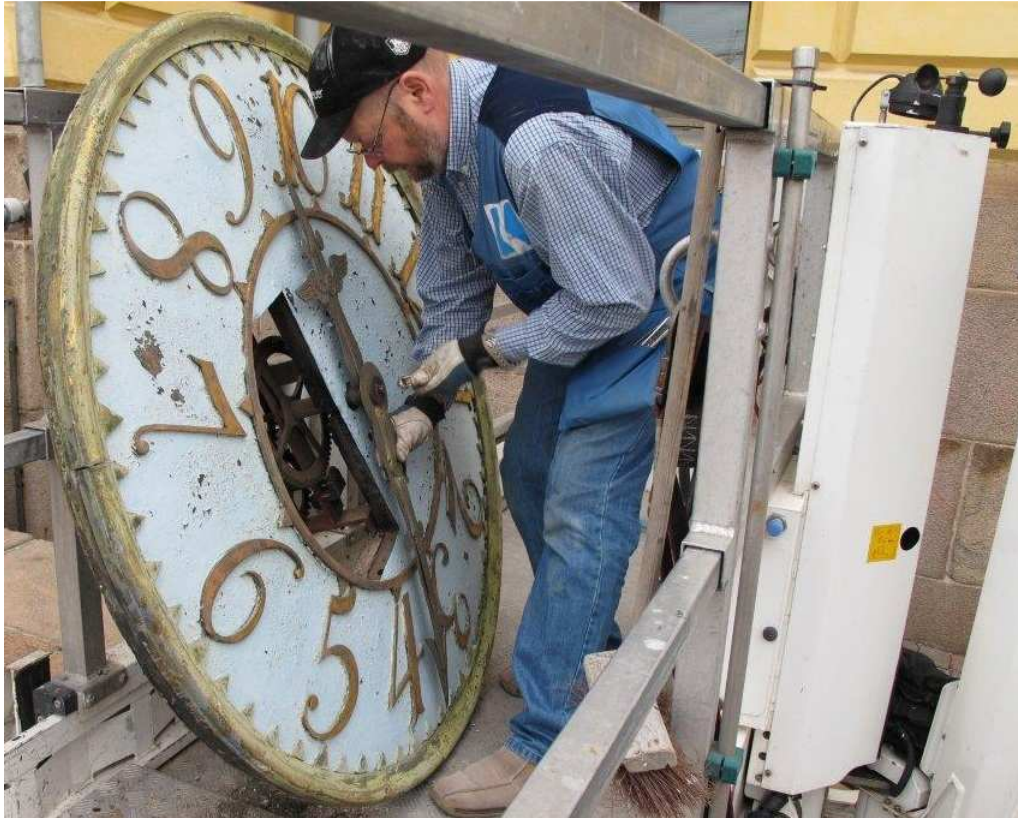
Kuva 18. VN1 eli Senaatintorin puoleinen kellotaulu ja Tapio Talja 6.9.2010. Kellotaulu oli viimeksi vaaleansininen ja ulkokehys vihertäväharmaa. Viisarit olivat lähinnä ruskeita, koska niiden kultaus oli hyvin kulunut. Alkuperäinen kuva © Ismo Tuovinen, Kello ja Kulta Widemark.
