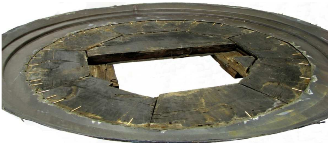
Kuva 50. VN2:n puinen kellotaulu messinkikehyksen kanssa 14.3.2011. Tulitikut ovat kiinnityskohtien paikoilla. Messinkikehys oli ruuvattu peltisen kellotaulun läpi puiseen kellotauluun.
