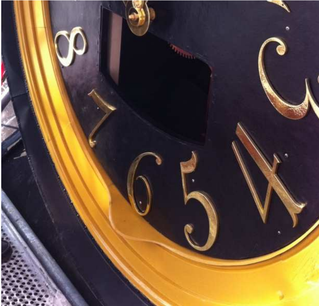
Kuva 81. VN2-kellotaulu kiinnitettiin alla olevaan puuhun pulteilla. Lähikuvassa VN2:n tippapelti ja vedenheittäjä. Kuvat 80 ja 81, Kultaus Oy Snellman 24.10.2011.
