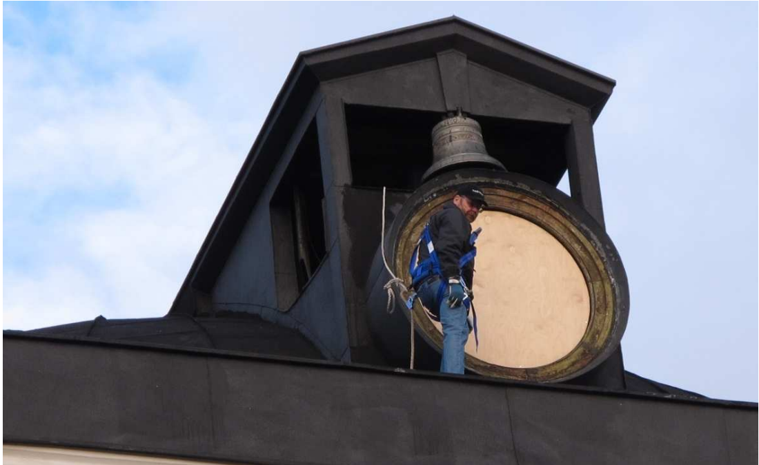
Kuva 17. Kelloseppä Tapio Talja on peittänyt VN2-kellotaulun vanerilevyllä 22.9.2010 kellokoneiston huoltamisen ajaksi. Kuva © Ismo Tuovinen, Kello ja Kulta Widemark
