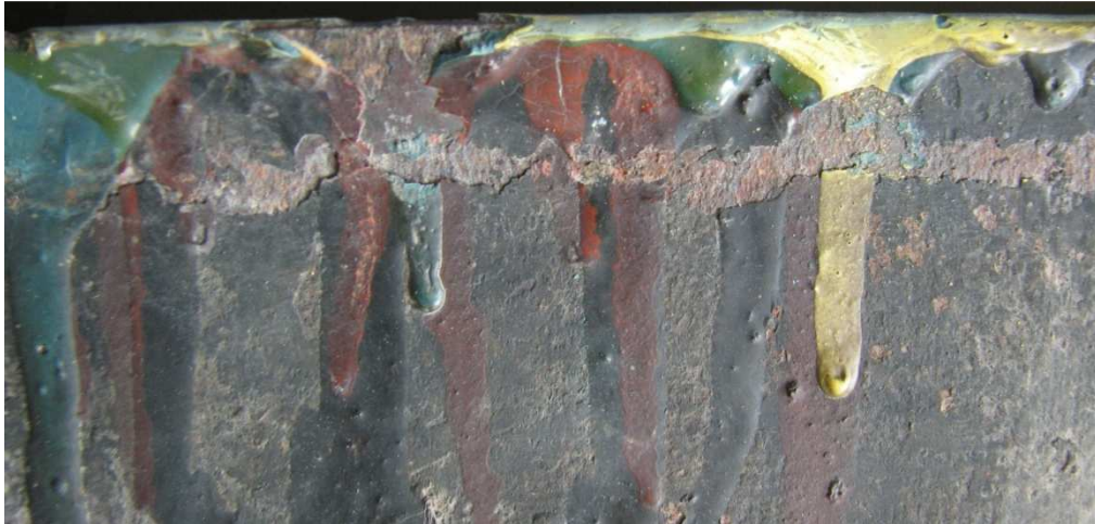
Kuva 65. Lähikuva VN2:n vanhemman huoltoluukun yläreunasta takaa, jossa on maalivalumia 29.10.2010. (1.) musta, punainen, (2.) turkoosinsininen, keltainen ja (3.) vihertävänharmaa.
