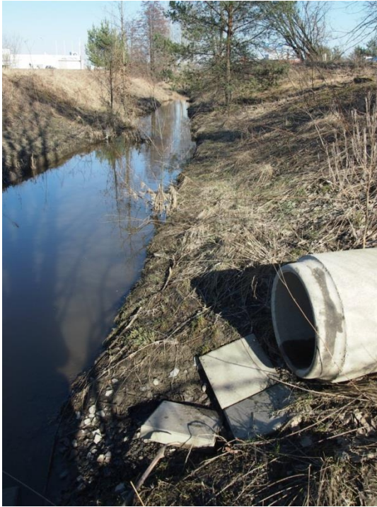
Kuva 15. Suikkilan kaupunginosan hulevesiviemäritä.
