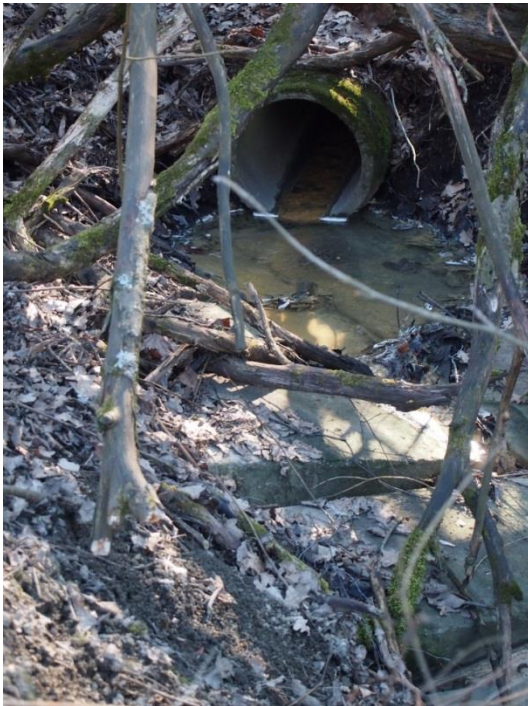
Kuva 16. Suikkilan koskialueelle purkautuva hulevesiviemäri.
