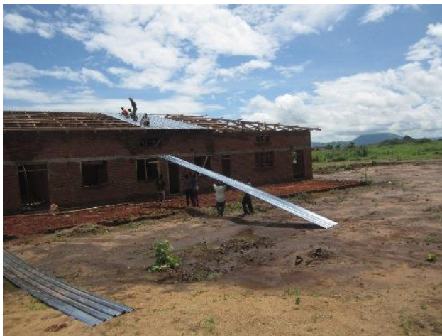
Kuva 2: Sairaala rakennusvaiheessa vuoden 2013 lopulla
