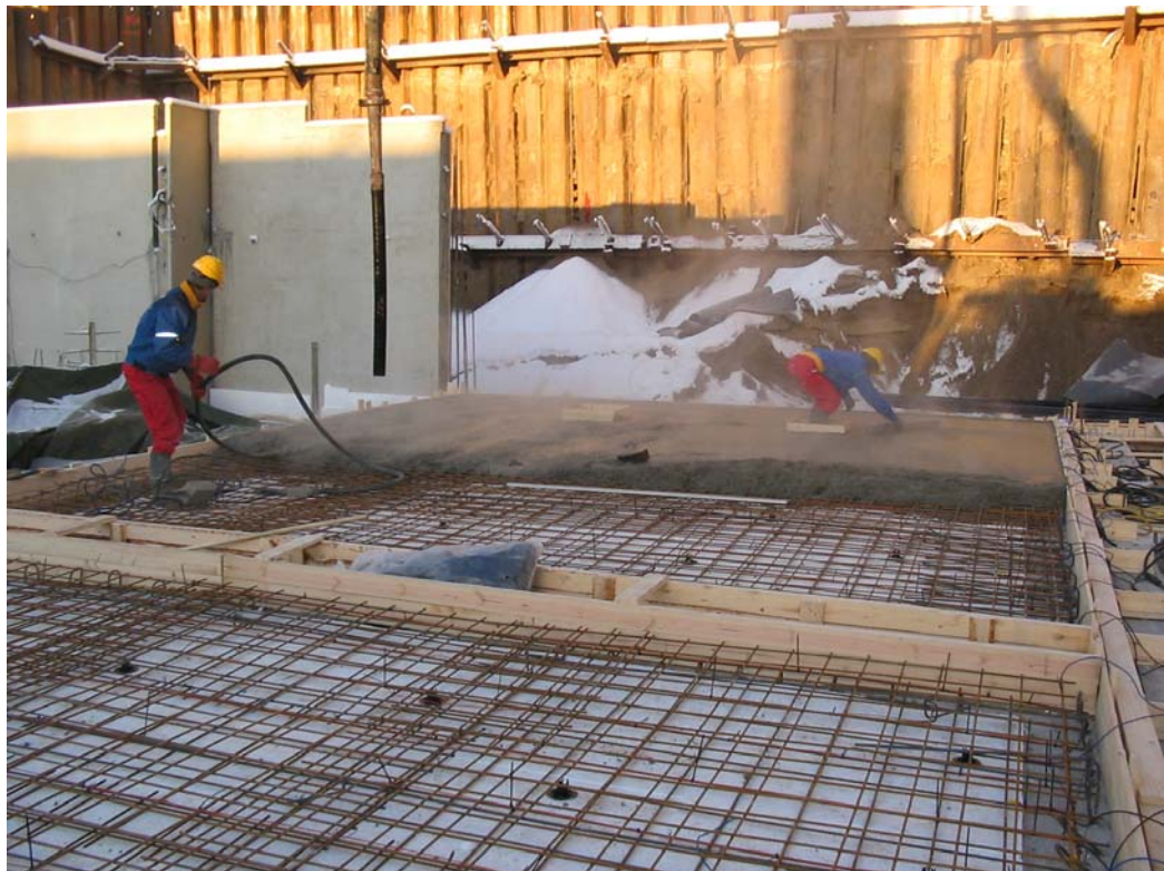
Kuva 2 Maanvaraisen laatan betonointi /6/
