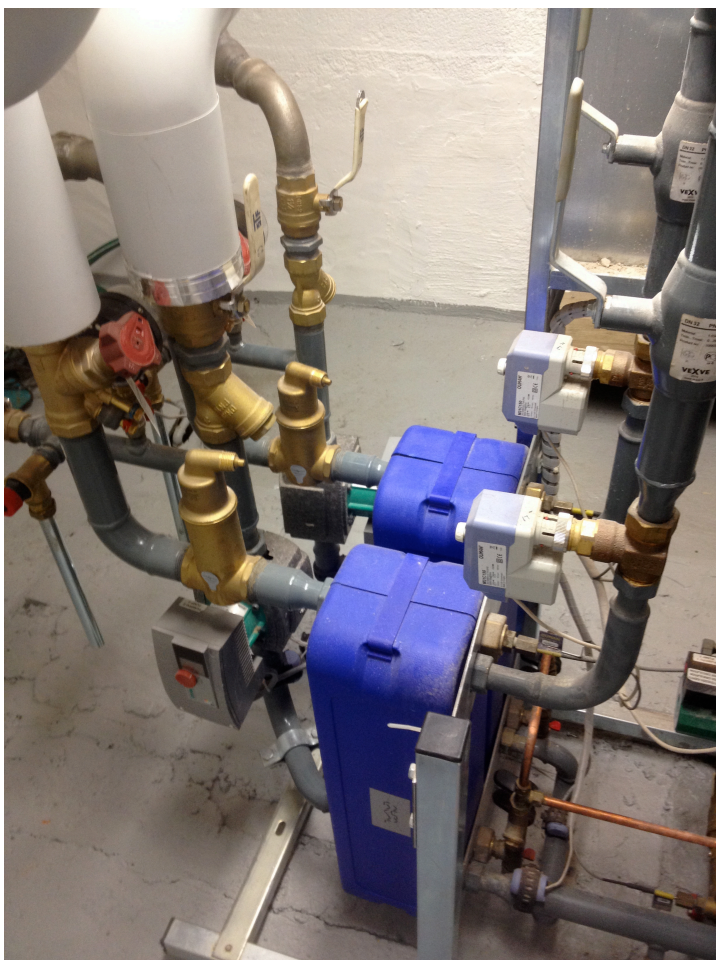
Lämmönsiirtimet lämmönjakohuoneessa
