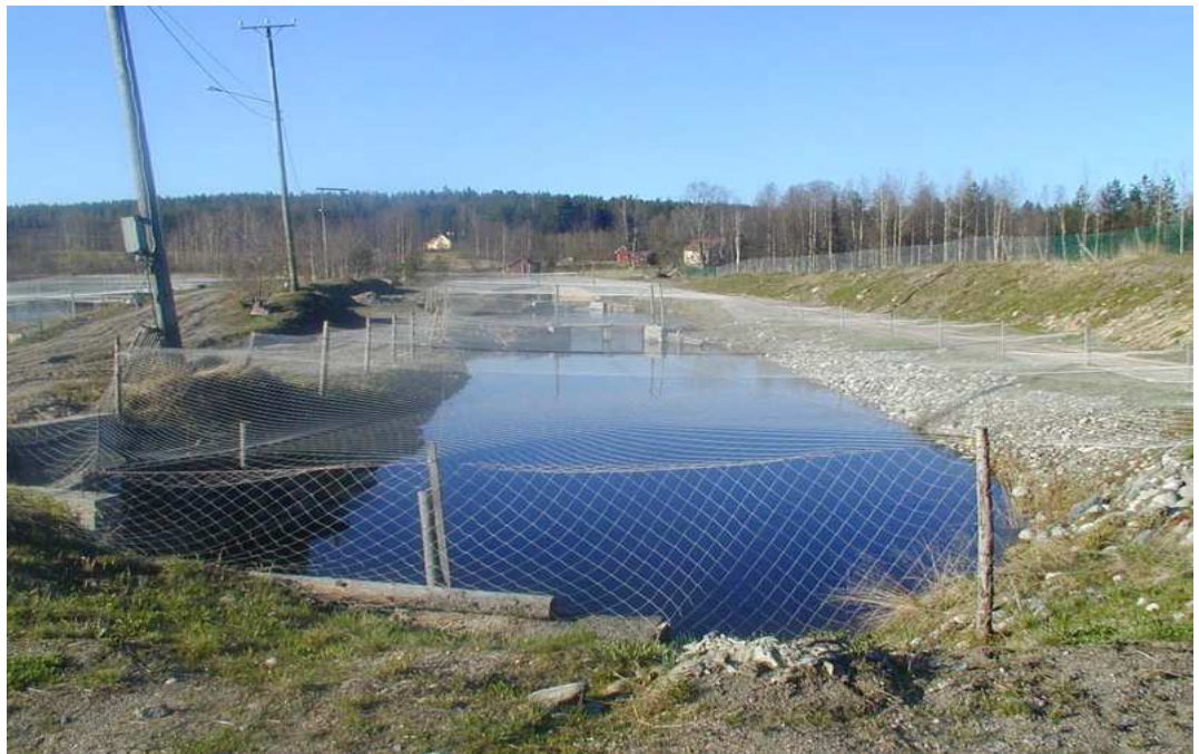
Kuva 1 Näkymä takimmaisten altaiden pohjoispäästä. Uudet läpivirtausaltaat sijoittuvat kuvassa oikealla sijaitsevan penkereen kodalle.
