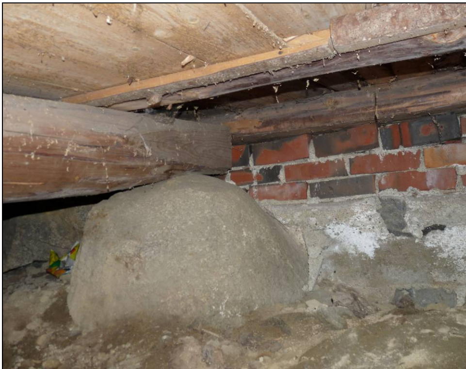
Kuvio 3: Rakennuksen perusmuuri ja perustuksena toimiva luonnonkivi
