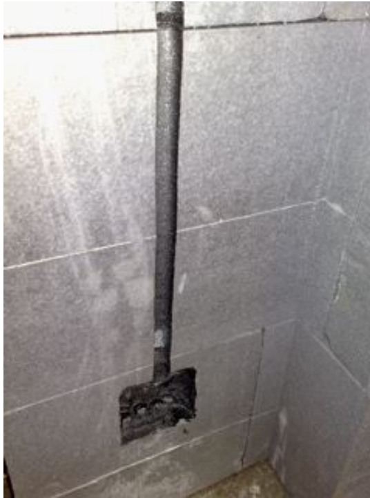
Kuva 13. Sisäpuolisen pistorasian asennus käy vaivattomasti lämpöurittajalla.
