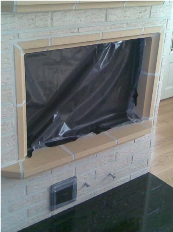
Kuva 5. Myös takan kautta tapahtuva ilmanvuoto estettiin.
